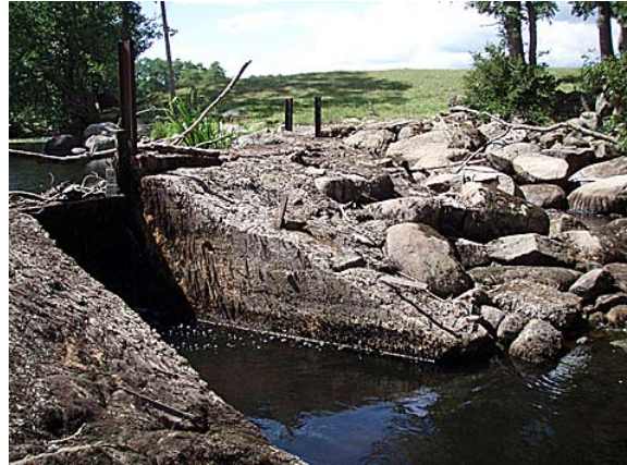
Figur 26. Kulturmiljö i form av ett dämme vid Sågmöllan som utgör vandringshinder nr 2. Foto: Jan Karlsson, Calluna AB.
