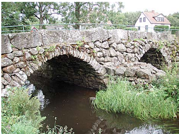
Figur 20. Stenvalvsbro vid vattendragssträcka 68 som utgör både strukturelement och nyckelbiotop av typen "Kulturmiljö i anslutning till vattendrag". Foto: Jan Karlsson, Calluna AB.
