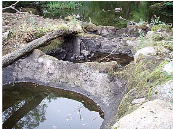
Figur 27. Vandringshinder nr 3 vid Tollarp. Fisktrappa som ej fungerar vid lågvatten. Foto: Jan Karlsson, Calluna AB.
