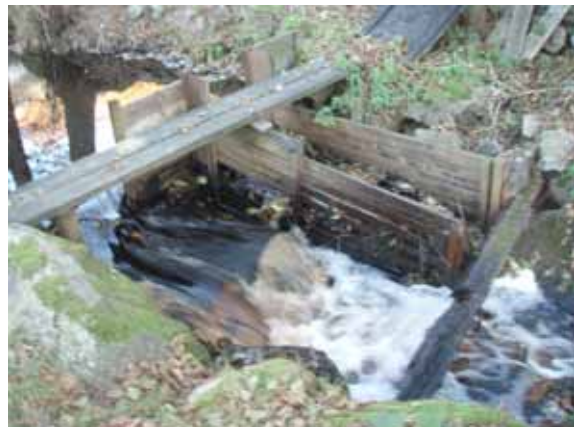
Figur 17. Ålkista vid Tofta, det enda vandringshindret i Toftabäcken. Hindret är partiellt bade för öring och mört. Fotograf: Jonas Johansson, Calluna AB.
