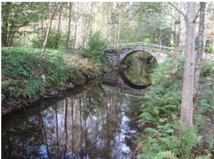
Figur 17. Nyckelbiotop, vacker stenbro över Ekeshultsån med korsande väg på A-sträcka 2 (Möllehem). I omgivningarna fanns gott om stensättningar, murar e t c. Foto: Jan Pröjts.
