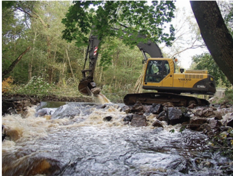
Restaureringsåtgärd, utrivning av dämme i Holjeån 2007.
