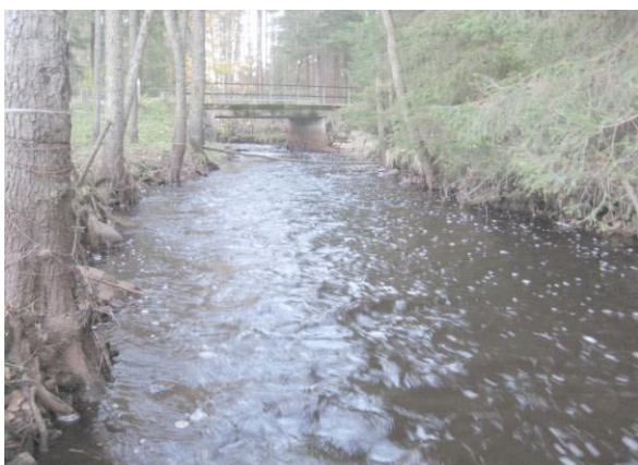
20-30 m nedströms bron.
