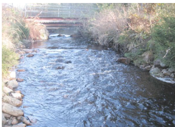
5-15 m nedströms bron.
