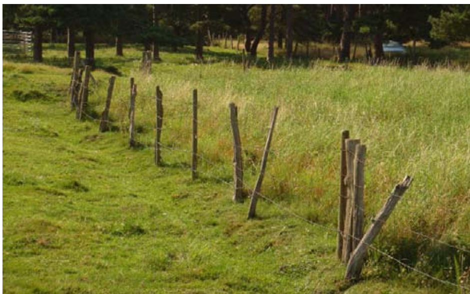
Fig. 18. Lokal 19. Den avbildade delen av stängslet i Norre fälä hyser flera stolpar med C. trachylioides , men kompletterande stolpar kommer att krävas inom kort eftersom en del står ostadigt.
