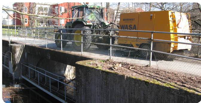
Saltning av gångbro över Skräbeån
