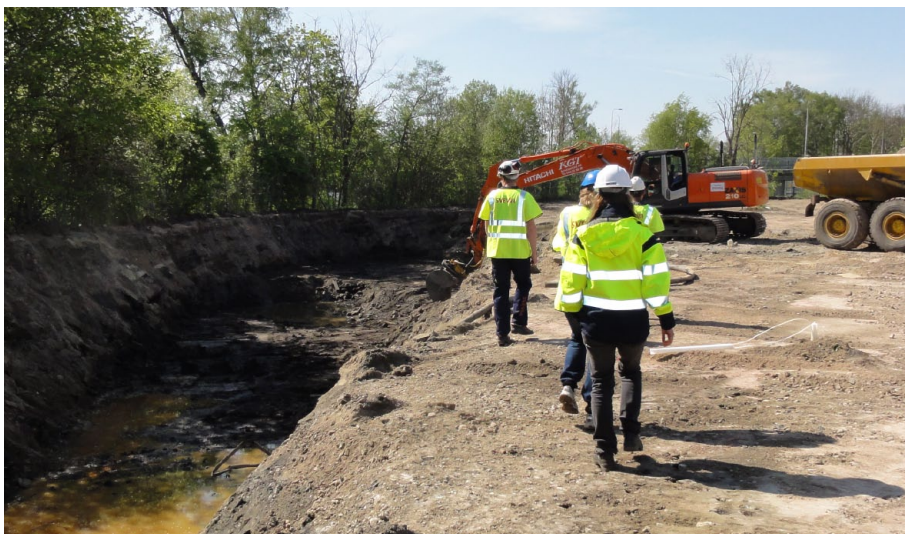
Sanering av mark och grundvatten vid Gasverket södra i Kristianstad.
