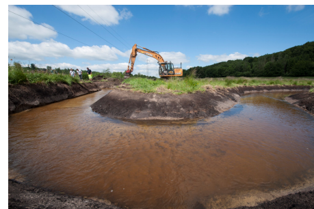
Grävning av meanderslinga. Foto: Johan Hammar.
