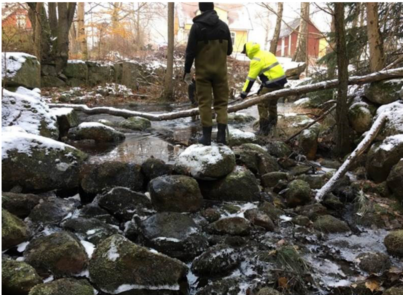
Bivarödsån. Huvudfåran frigörs vid en kvarnanläggning. Foto: Fredrik Lundmark
