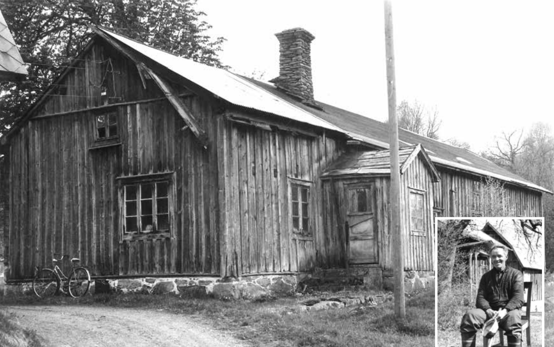
ROBERT NILSSON (1905–1998) och det nedgångna boningshuset på östra gården omkring 1980.
