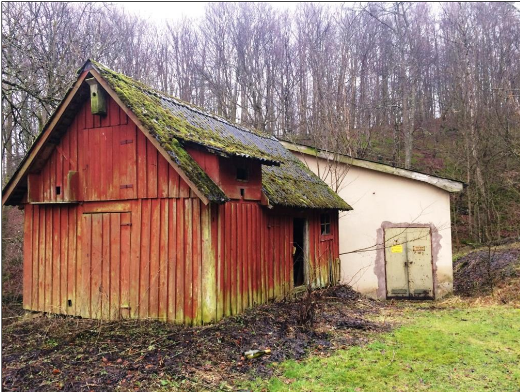
Bild 3. Magasinsbyggnaden sedd ifrån norr.
