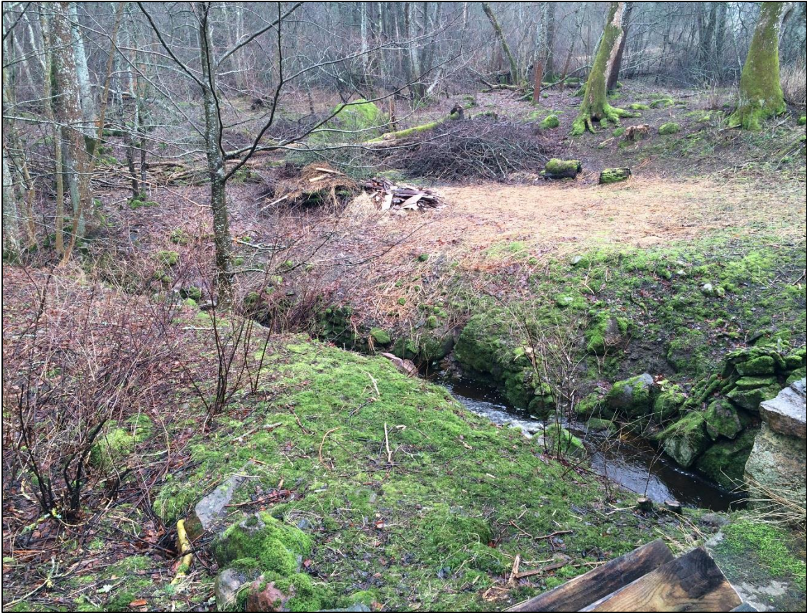
Bild 6. Den stenskodda utloppskanalen.
