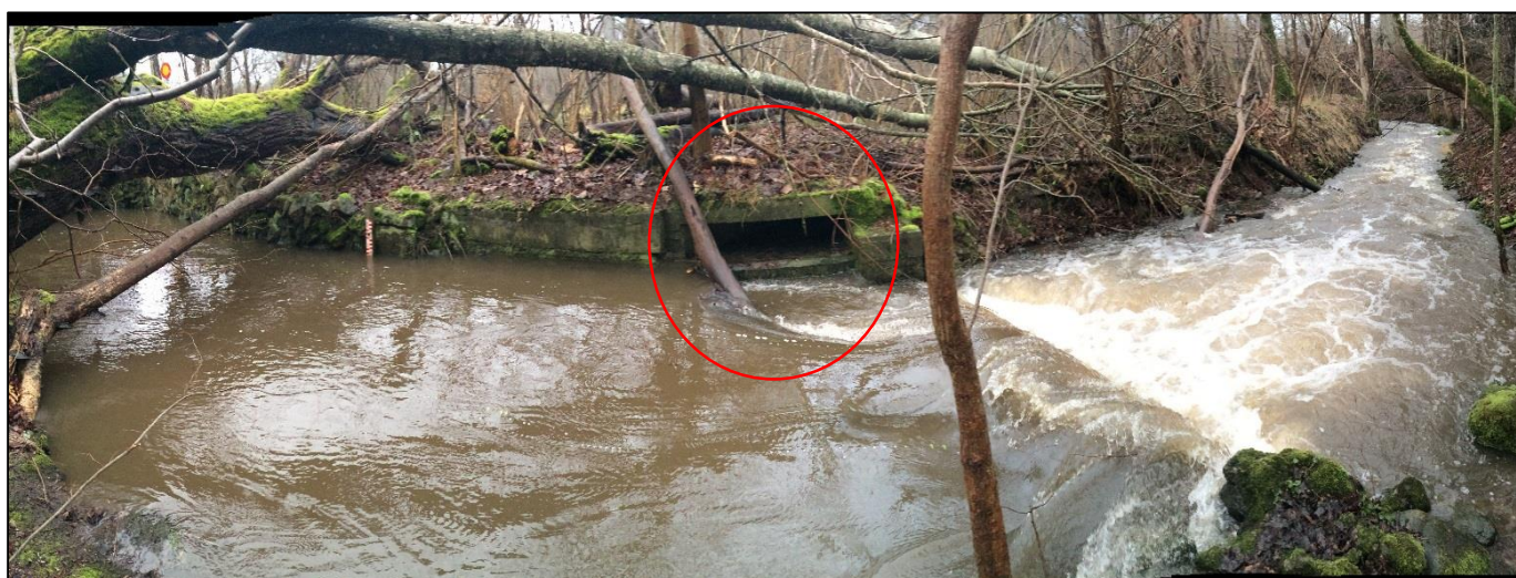
Bild 2. Överfallsutskovet reglerar vattentillförseln till det kulverterade intaget (röd markering) till hålldammen.
