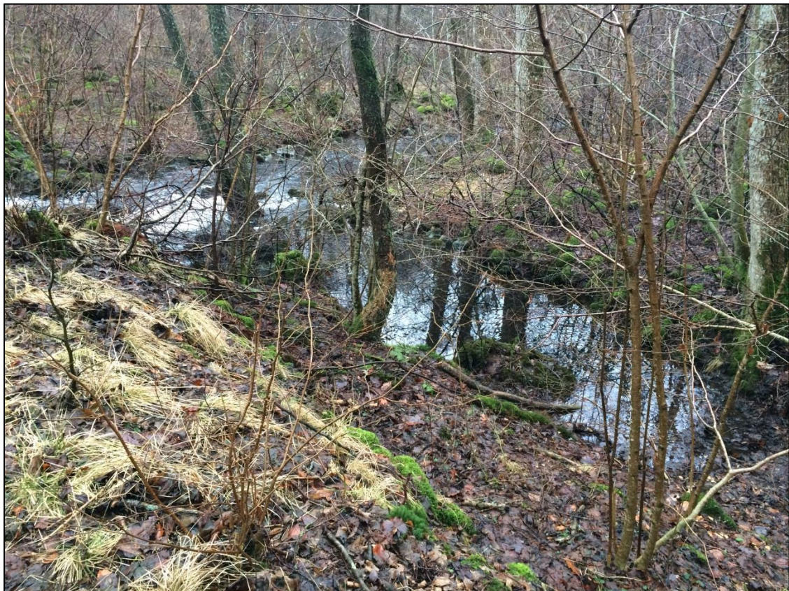
Bild 3. Vy nedanför dammen. Notera den lilla vattenfyllda bassängen hitom vattendraget.
