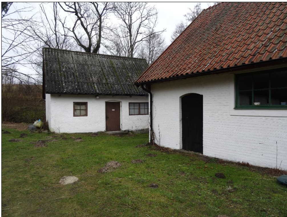
Bild 6. Del av stall- och loglängan syns till höger i bild och till vänster syns svinhuset.
