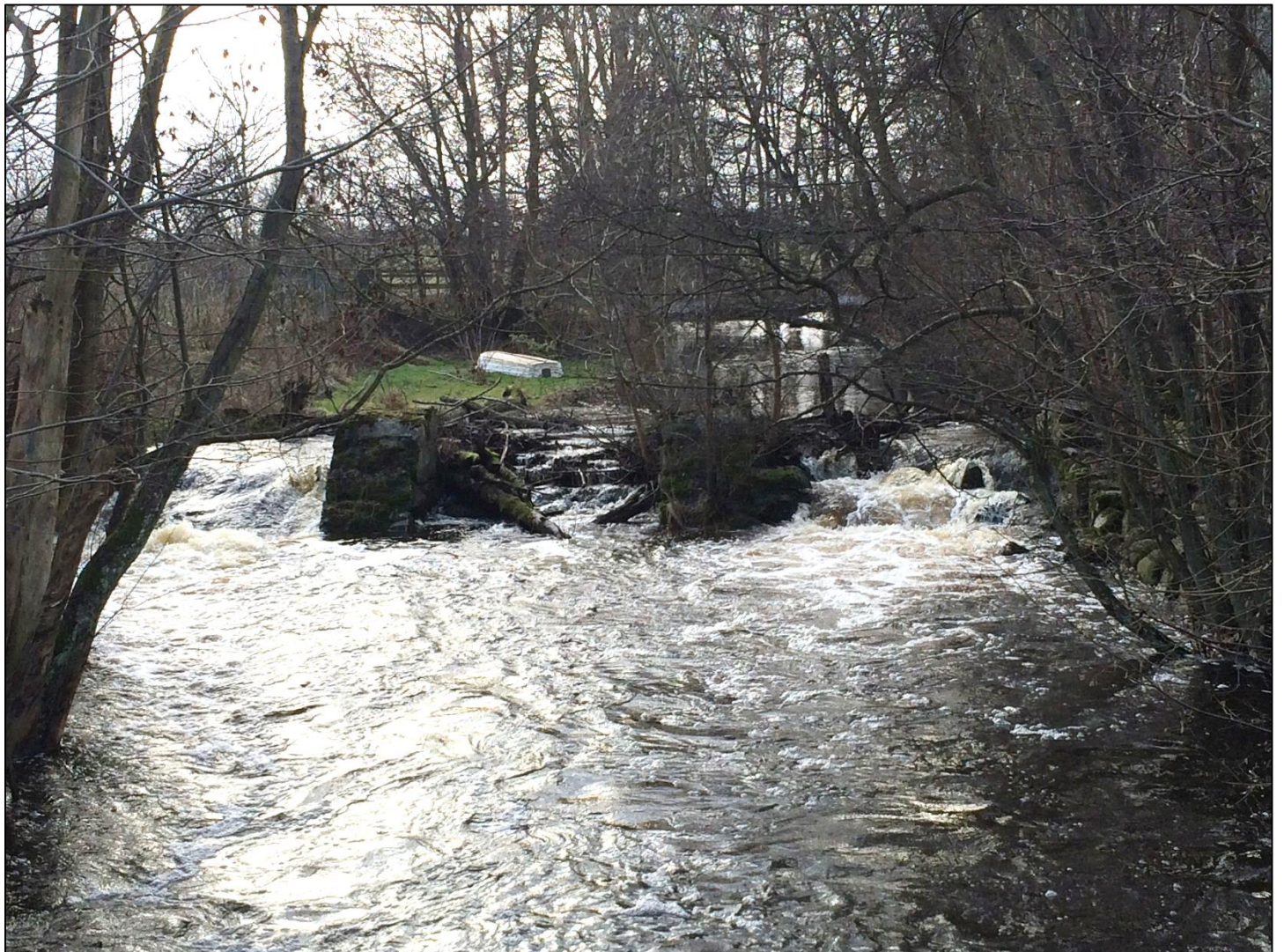
Bild 4. Dämmet vid Lyngbymölla.
