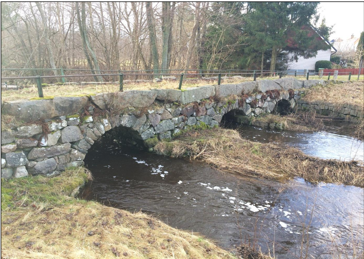
Bild 6. Stenvalsbron över Mjöån uppströms kvarnen.
