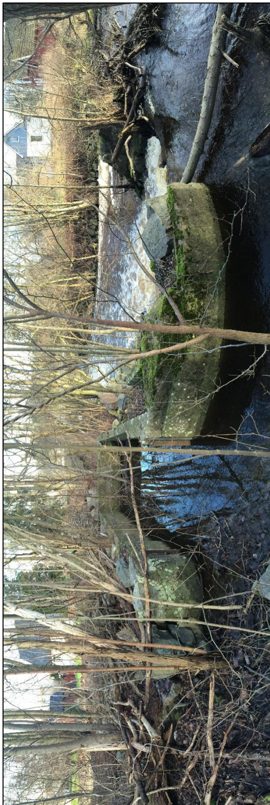
Bild 1. En panoramavy över kvarnområdet. T.v är grundmuren efter kvarnbyggnaden med turbinsump och intag. T.h. dämmet.
