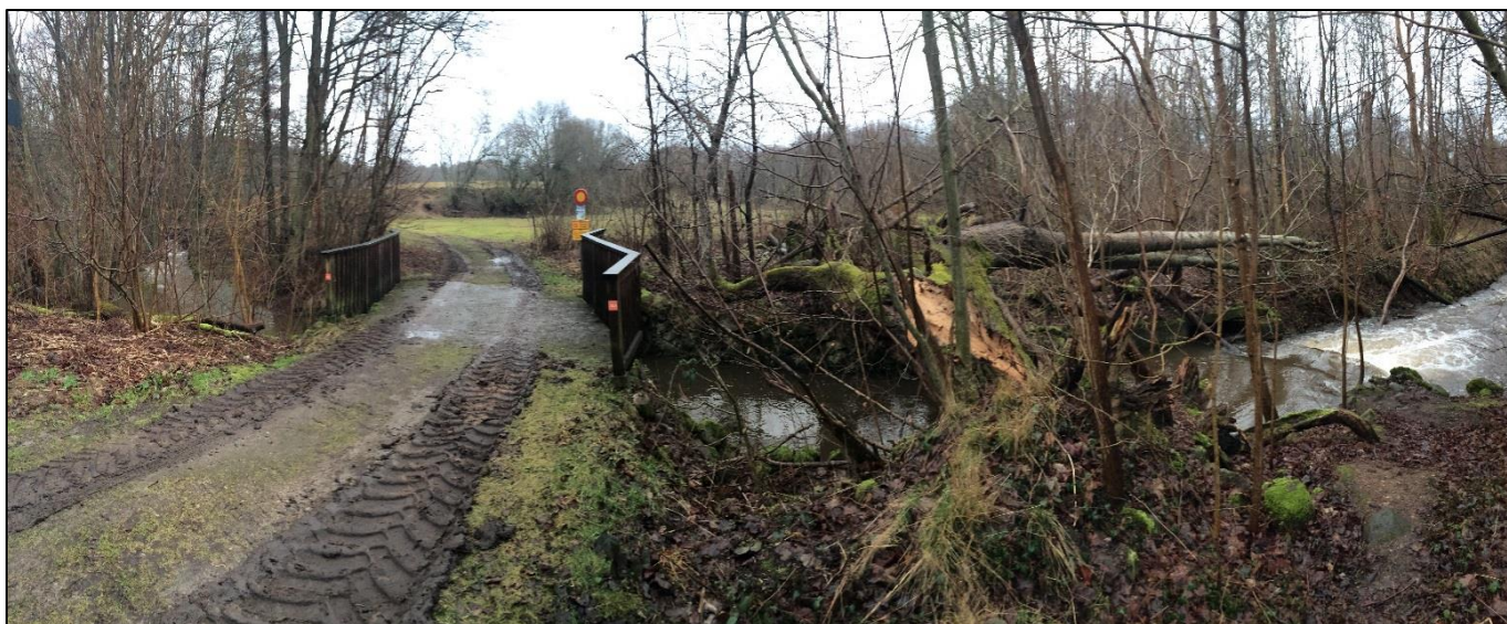
Bild 1. Dämnet i Rörums Norra å. T.v. syns bron över vattendraget och t.h. dämnet som reglerar vattentillförseln till hålldammen.
