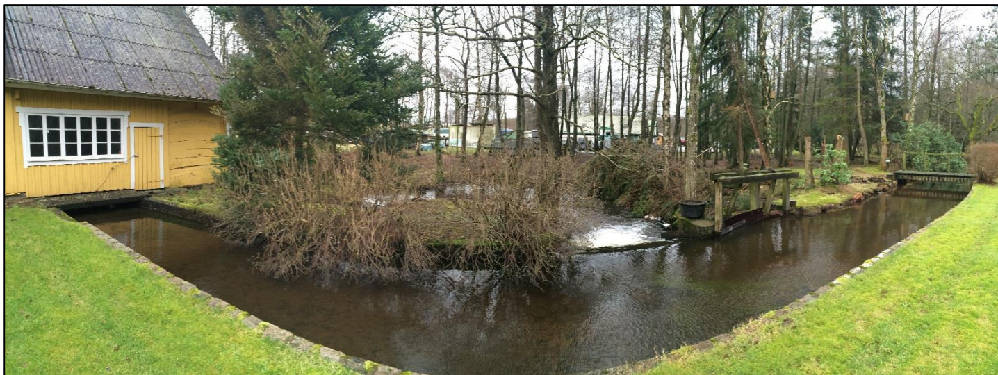
Bild 1. Det långsmala dämnet/intagskanalen till Dymöllan.
