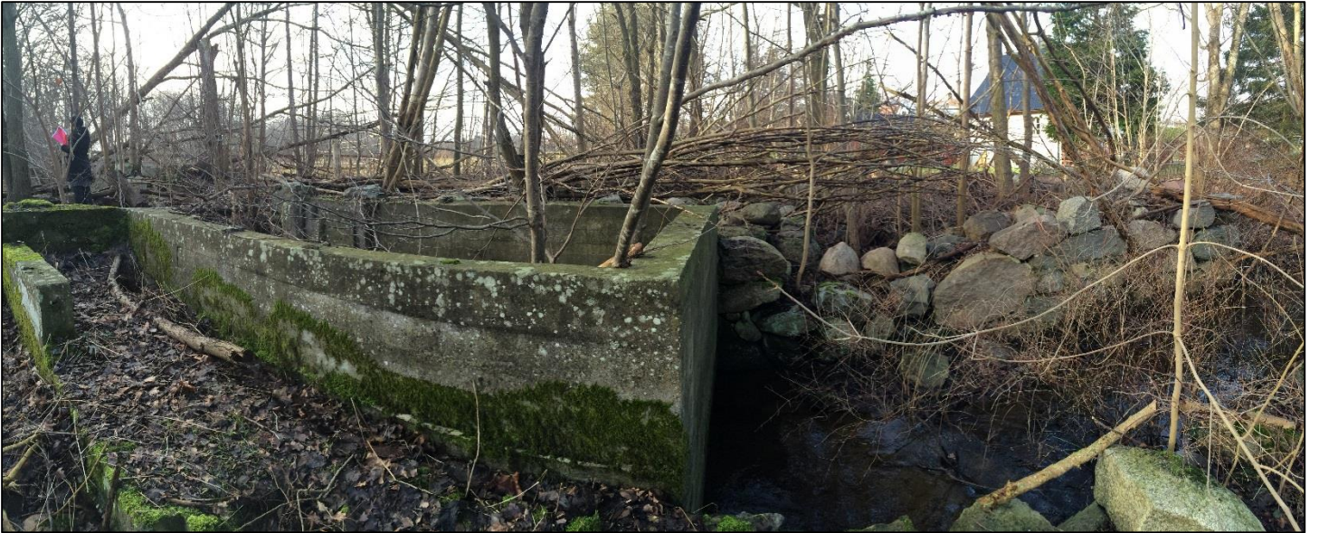
Bild 3. Turbinsumpen och den stensatta utloppskanalen/hjulgraven.
