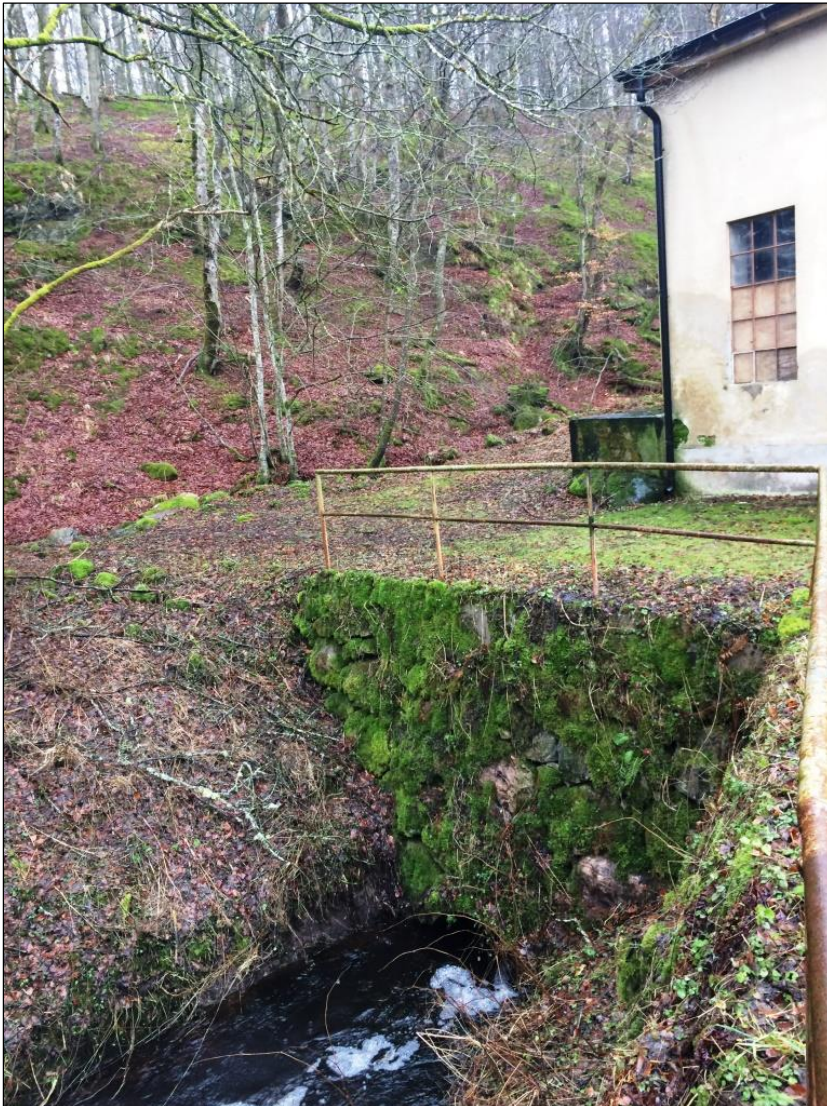
Bild 10. Utloppskanalen som delvis löper under kraftstationen.
