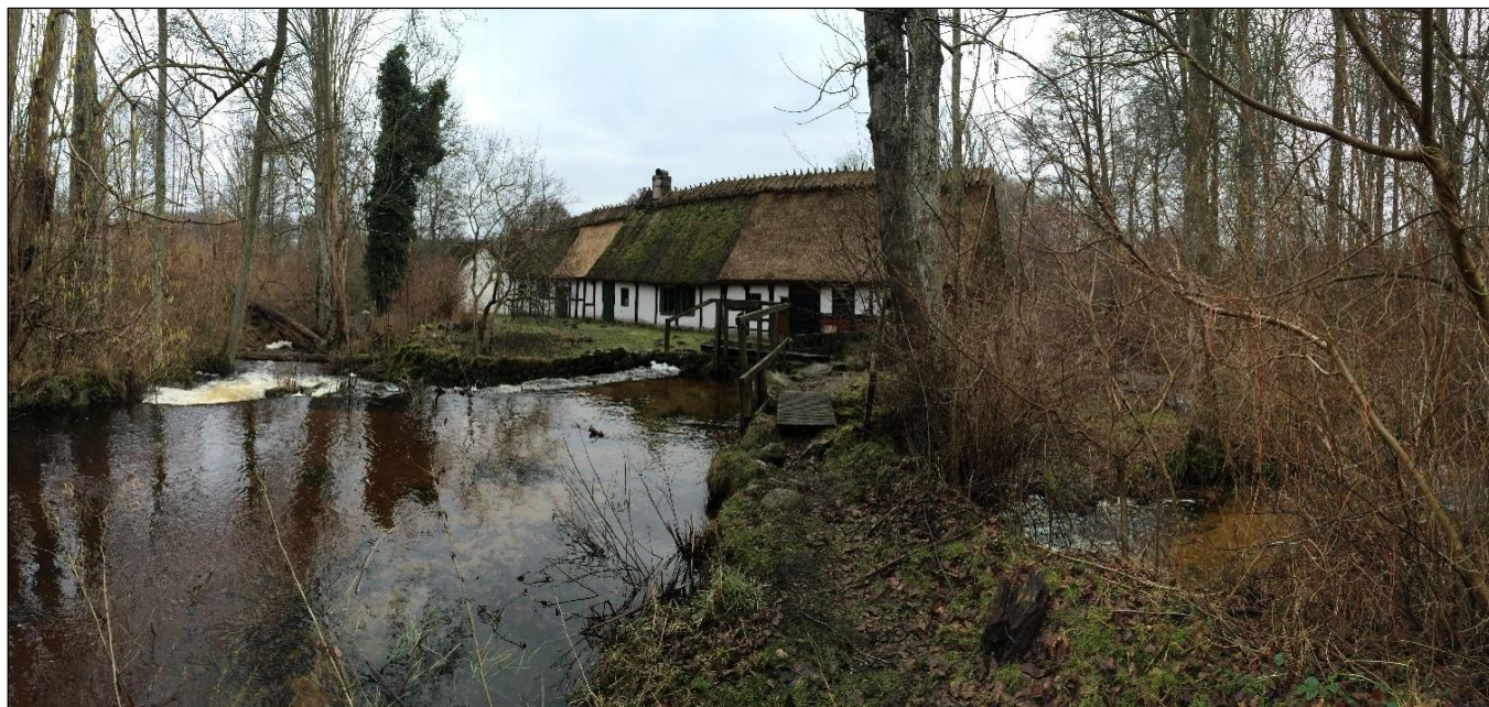
Bild 7. Dammen och kvarnen sett från nordväst. Till vänster är överfallet, i mitten kvarnintaget och till höger reservutskövet.
