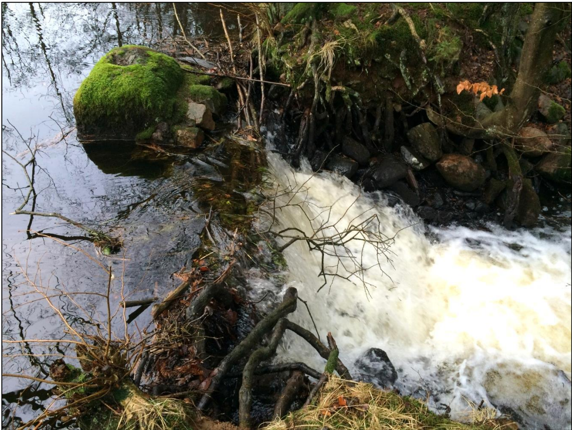
Bild 9. Utskov med tröskel i kallmurad sten.
