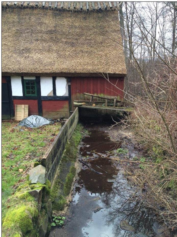
Bild 9. Intagskanalen till vattenhjulet med betongförstärkt kant.
