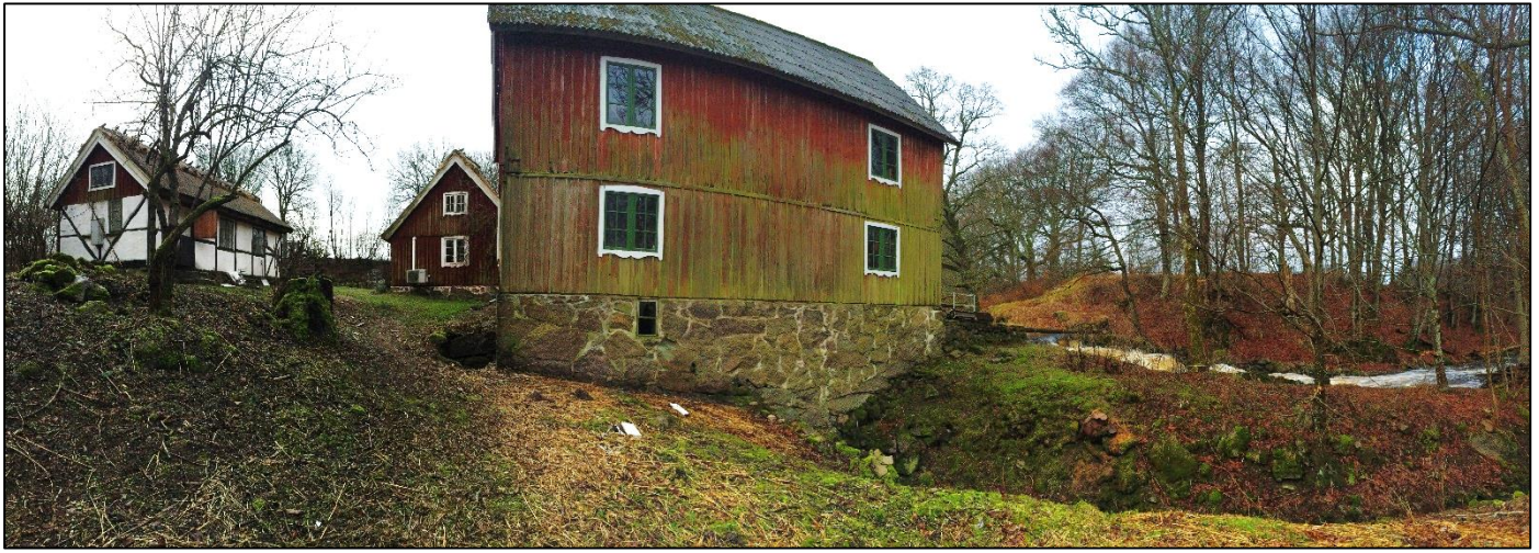
Bild 7. Baksidan av kvarnbyggnaden med utloppskanalen vid sidan om vattendraget.
