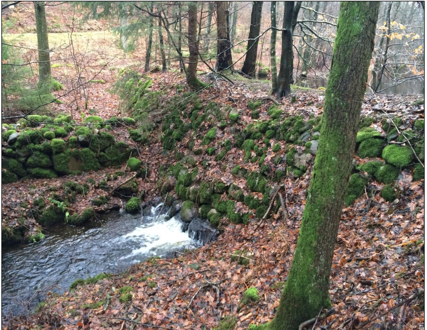
Bild 11. Det tredje dämmet. Den gedigna skalmursdammen.
