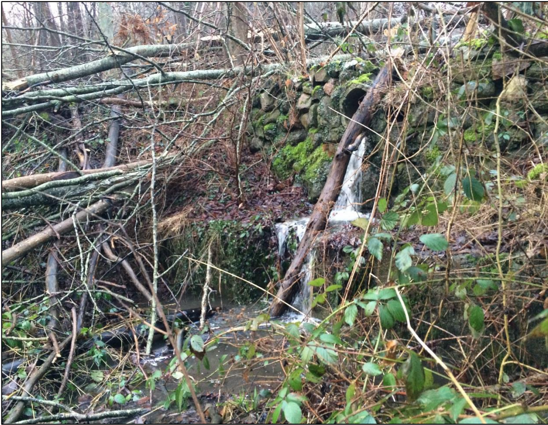
Bild 3. Det kulverterade intaget avleder vatten till en intilliggande grävd hålldamm.
