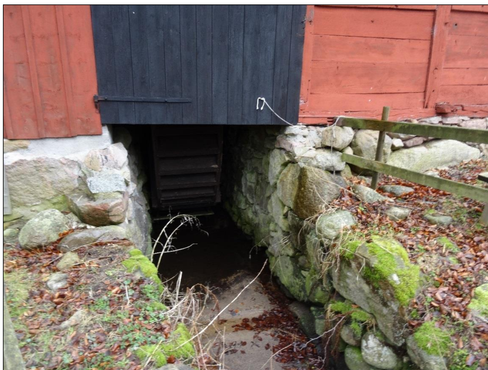
Bild 10. Den stenskodda kvarnrännan med bröstfallshjulet.
