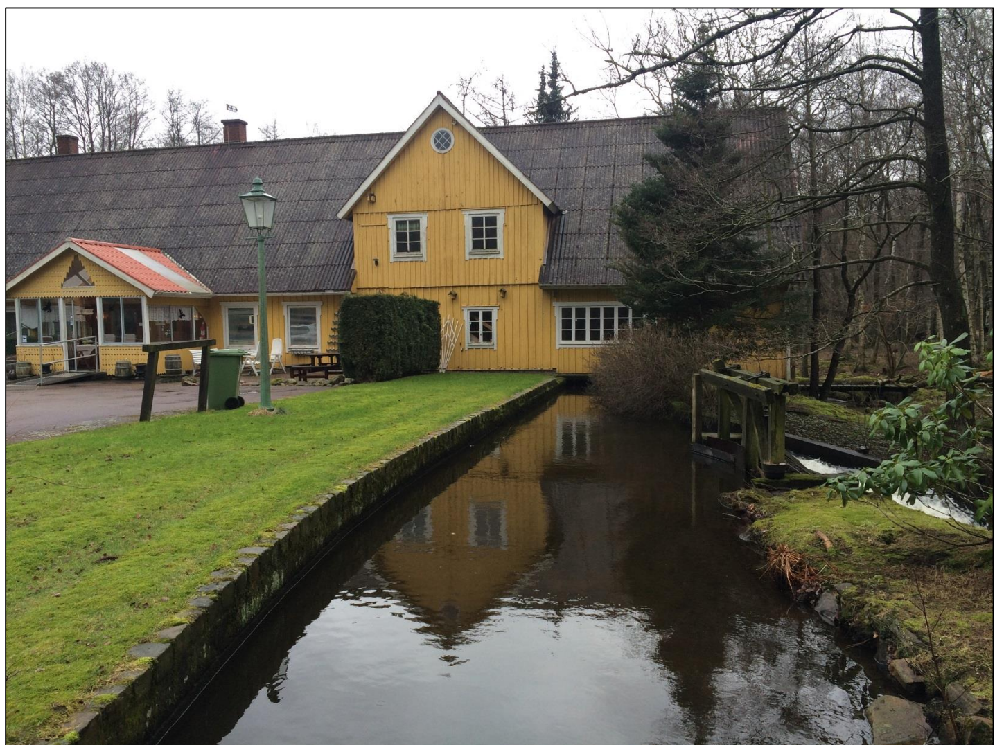
Bild 2. Det långsmala dämnet/intagskanalen till Dymöllan. Strandbrinken är kallmurad med tuktad sten.
