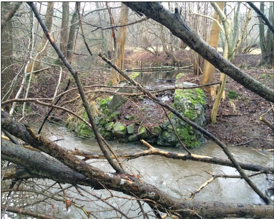
Bild 4. Utskovet från hålldammen till vattendraget.
