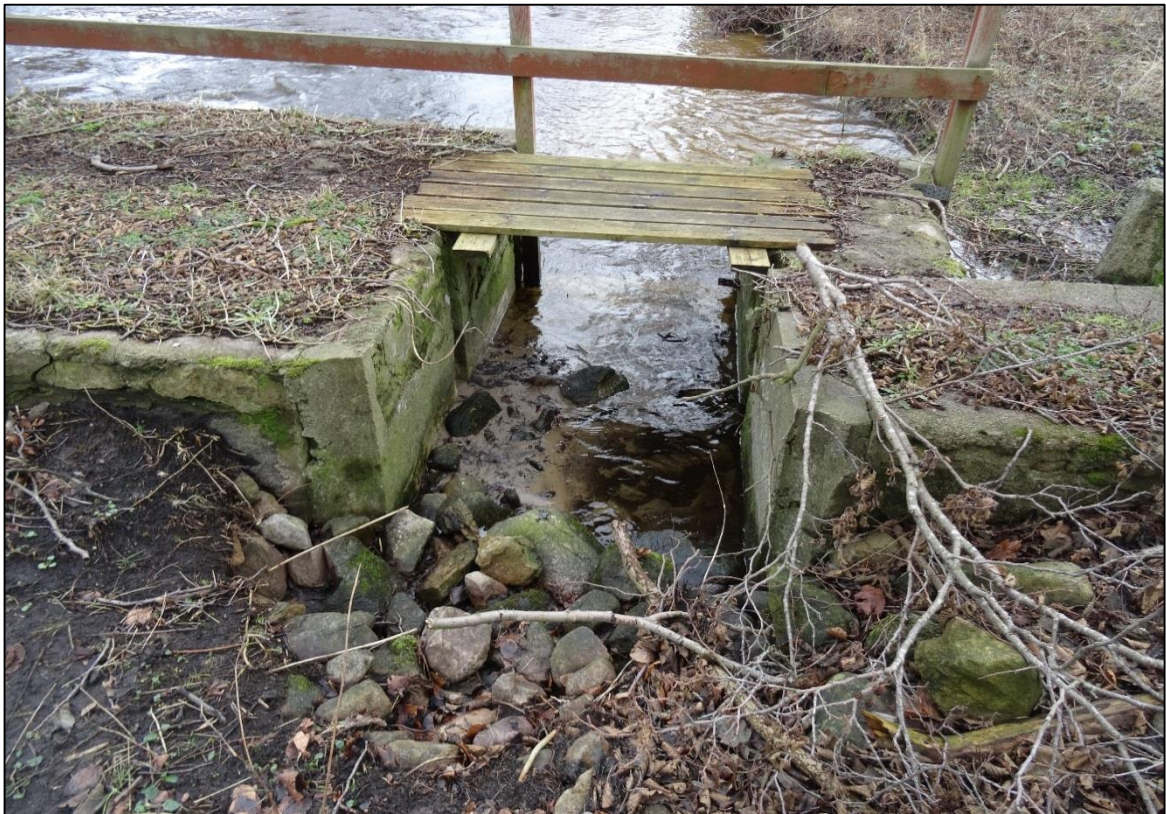
Bild 4. Ett par av utskoven är igensatta.
