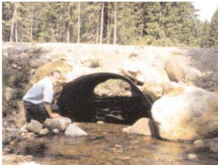
En nedgrävd heltrumma medför nästan alltid en negativ påverkan på vattendraget. Det finns alternativ. Här har SCA skog lagt en halvtrumma av en skorsten och på detta sätt erhållit en naturlig bäckbotten. Foto Oskar Norrgrann.
