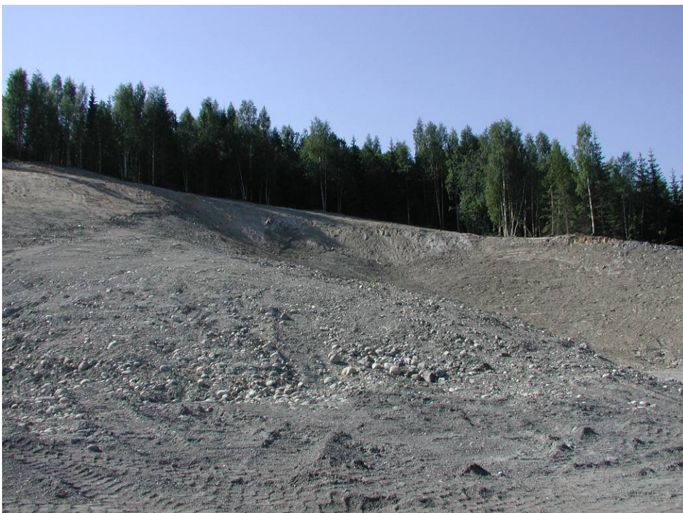
Bergtäktens exponerade läge bidrog till valet av efterbehandlingsmetod, snedsprängning och släntning. Foto: Länsstyrelsen i Västernorrlands län.
