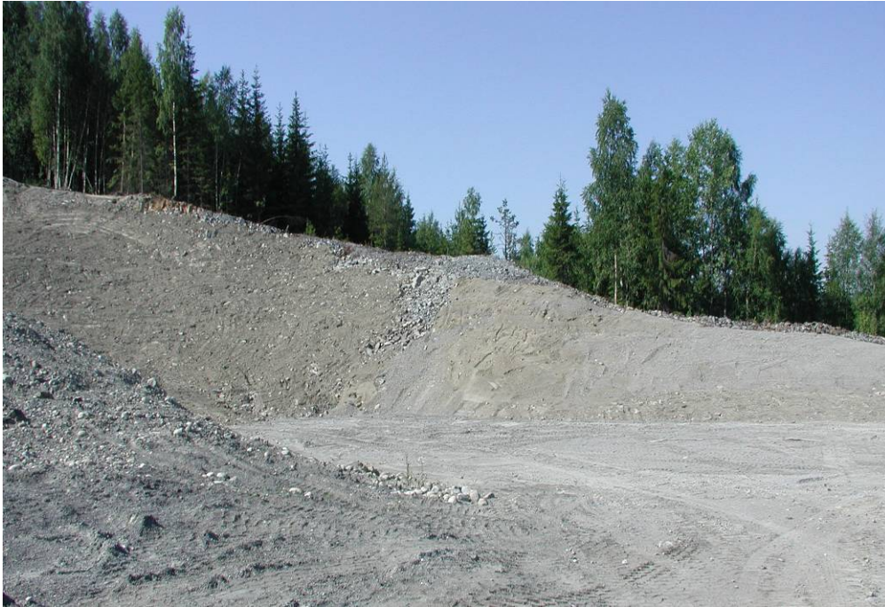
Efterbehandlingen utfördes genom snedsprängning, sedan spreds avbaningsmassorna ut över slänterna. Foto: Länsstyrelsen i Västernorrlands län.
