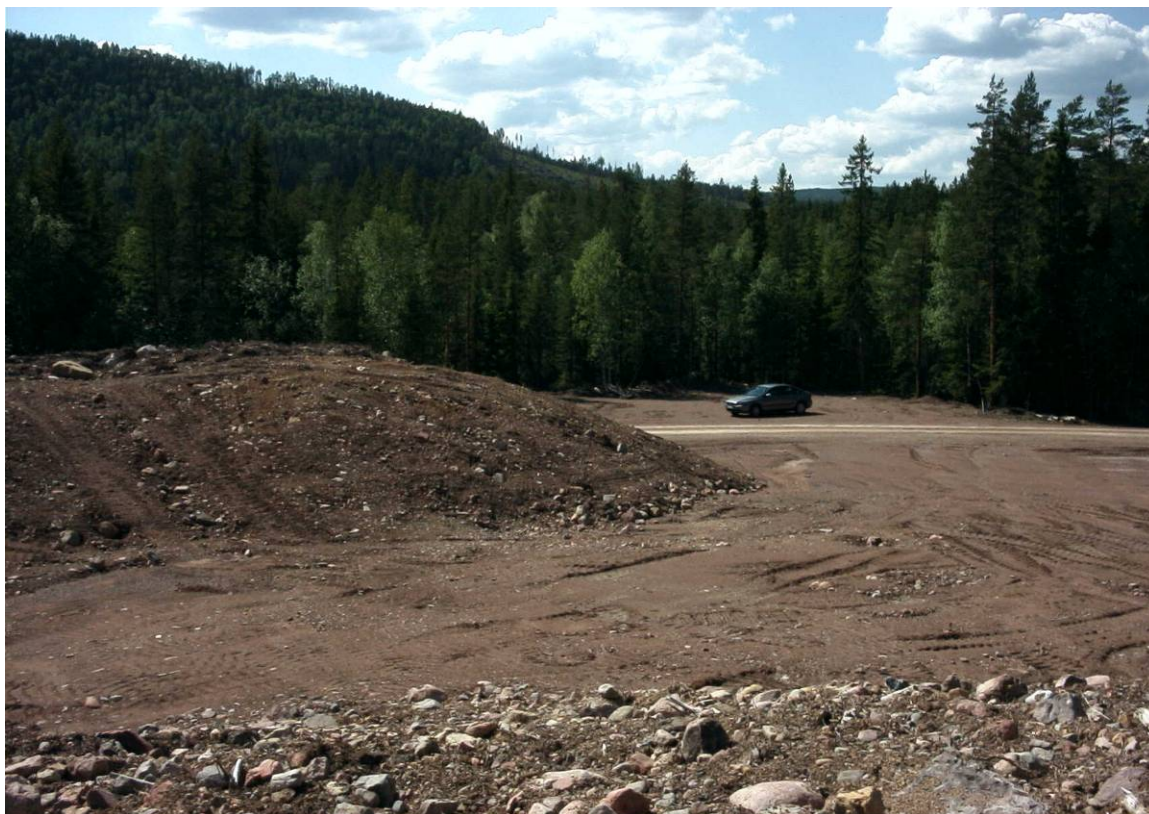
Moräntäkt, efter utförd släntning. Täktbotten lämnades kvar för framtida lagring av timmer. Foto: Länsstyrelsen i Dalarnas län
