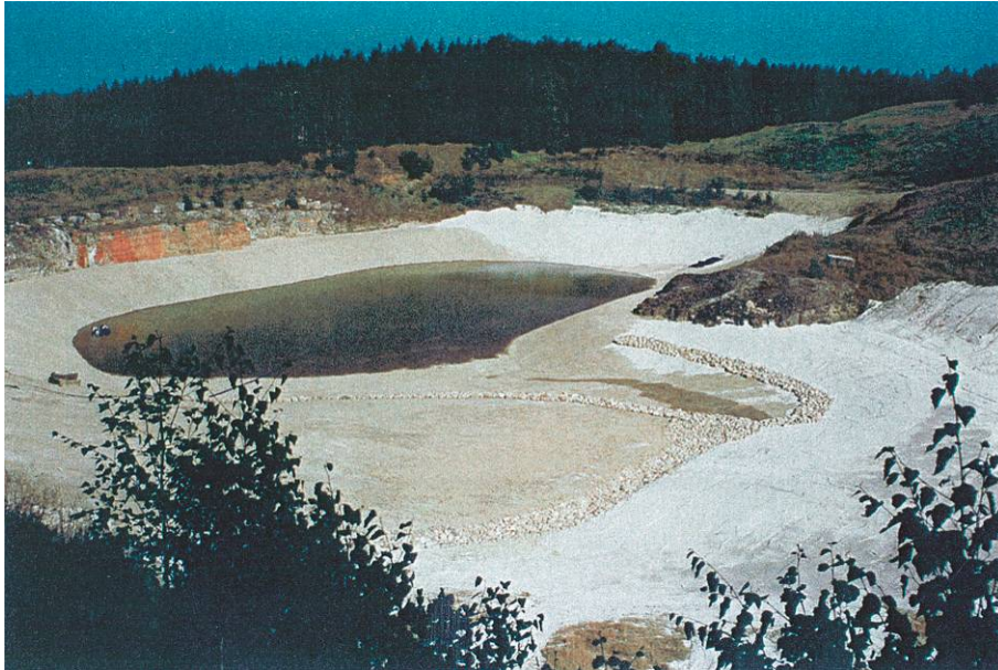
Tätningen med moränlera utfördes 1992 för att återskapa vattenspegeln i täkten. Foto: Lars Wikström, Mark och Landskap.
