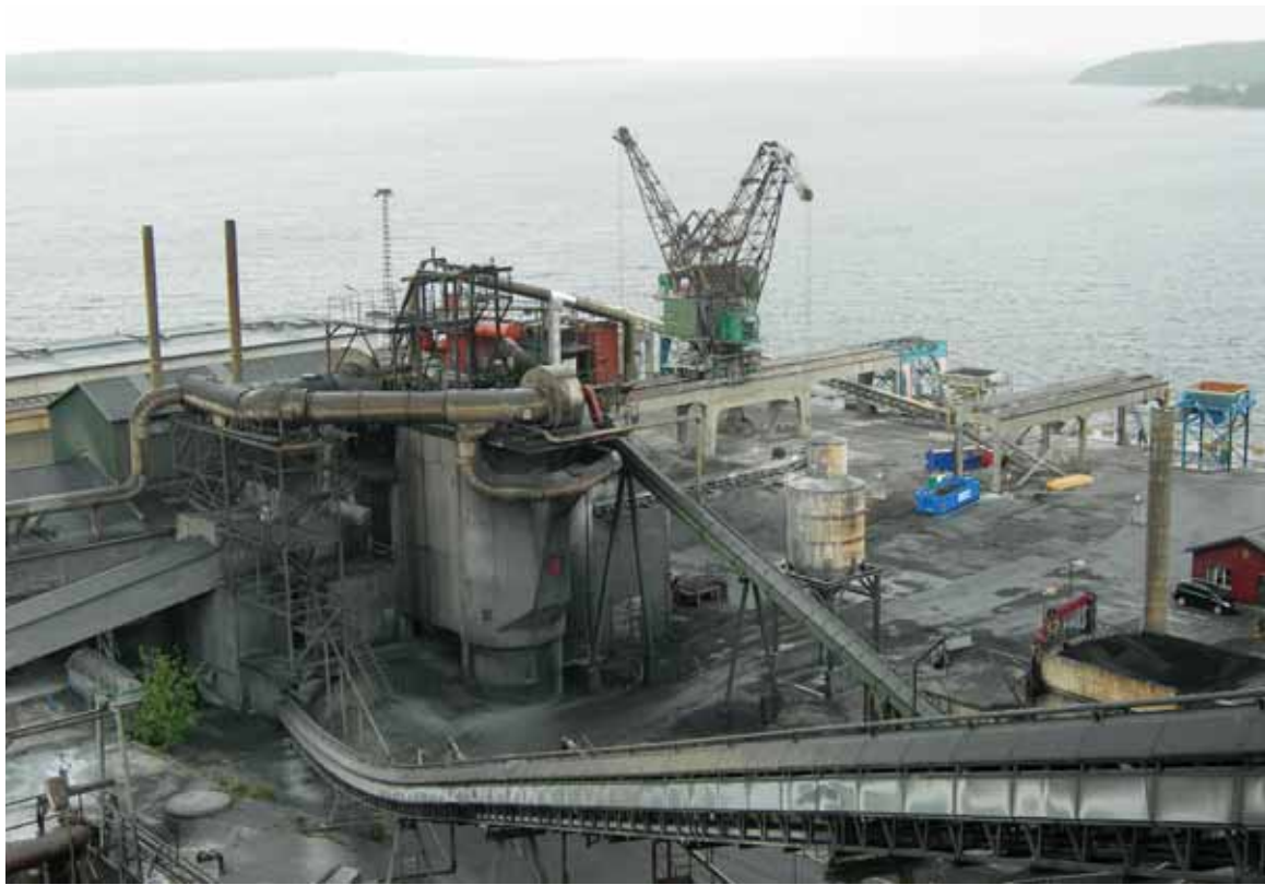
Den hisnande utsikten från ugnshusets tak ger en bra överblick av fabriken hamn med sina kranar. I det större byggnadskomplexet torkas koks som används i karbidframställningen, den långa branta bandtransportören levererar bränd kalk och torkad koks till karbidugnen. En tunn hinna av koks täcker sedan länge hela fabriksområdet. Foto LKU 2007
