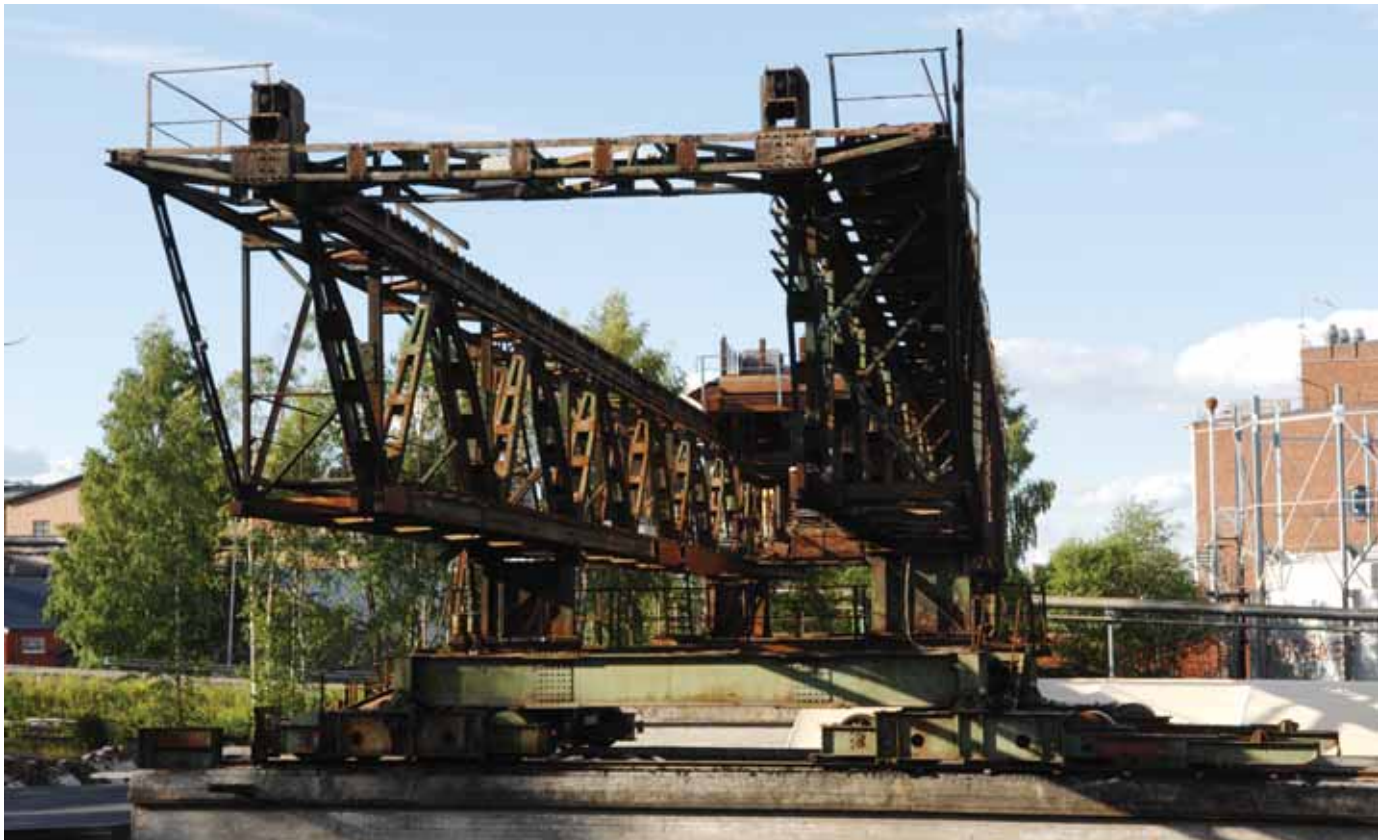
Bilden visar den ursprungliga brokran som benämndes "bunkerbryggan" och som levererades av det tyska företaget DEMAG i början av 1940-talet. Hela fackverkskonstruktionen demonterades och såldes som skrot i slutet av år 2007. Foto SOA 2007
