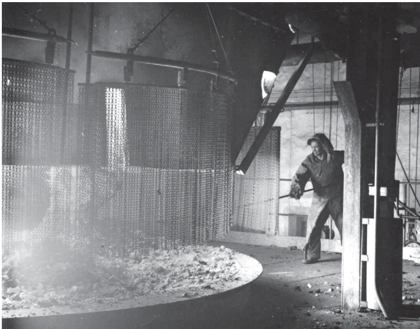
Samma ugn som på motstående sida men under drift. Bakom kättingdraperierna kan en av ugnens elektorder skönjas och man kan riktigt känna hur strålningsvärmén från smältan hettar i ansiktet på mannen som snyggat till överdelen på chargin. Arkivfoto Carbide Sweden AB, Stockvik
