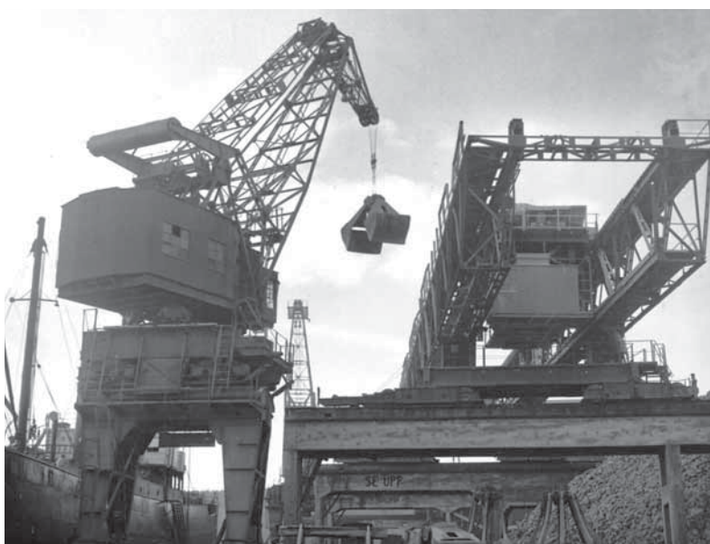
Lossning av fartyg med kalkstenslast sannolikt från Furillens kalkbrott på norra Gotland. Den stora portalkranen närmst i bild hade 6 tons lyftkraft och betjänade alla fartyg som lossades i hamnen. I bakgrunden syns den andra kranen på kajen. Högbanan till höger i bild var bestyckad med en brokran som levererades av den tyska firman DEMAG. Brokranen skrotades under hösten 2007. Arkivfoto Carbide Sweden AB, Stockvik
