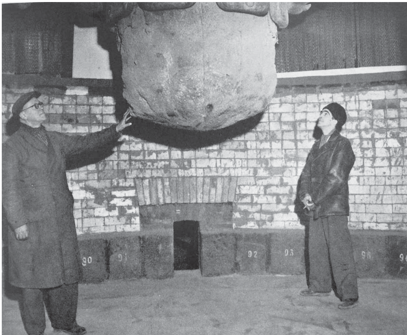
Bilder inifrån karbidugnen är mycket ovanliga. Här ser man dock två representanter från företaget som begrundar spetsen på en av elektrodena i samband med att ugnen har murats om. Hålet i murverket är ett av tre tappställen för den smälta karbiden. Faximil ur Syntesen nr 1, 1952, Tekniska museets arkiv, Stockholm
