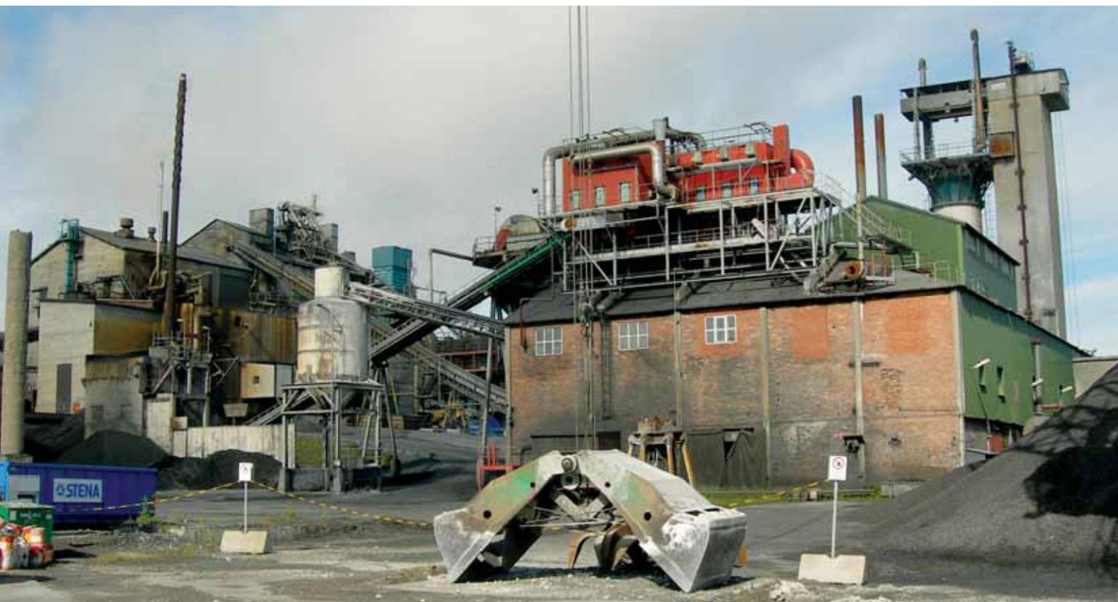
Anläggningen sedd från hamnen. Notera de stora slangfiltren på kokstorkhusets tak. I förgrunden står den norra kranens gripskopa i väntan på nästa råmaterialeverans. Foto LKU 2007
