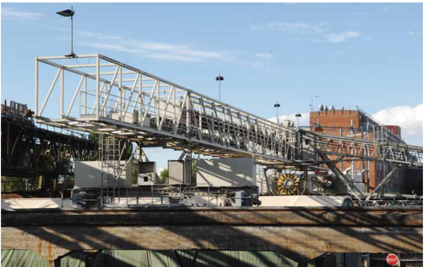
Den nya bunkerbryggan är en svetsad fackverkskonstruktion som effektivt fördelar råvarorna kalksten och salt till respektive platser på det stora upplaget. Saltet används vid kloratframställning i en annan del av Stockviksområdet. Foto SOA 2007
