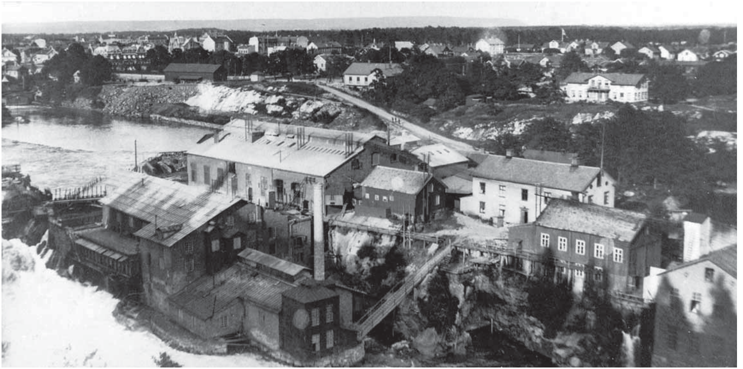
Trollhättans karbidfabrik placerades på ön Önan där det redan fanns ett flertal vattendrivna verk bl.a. Sveriges första massasliperi etablerat i mitten av 1870-talet (byggnaden mellan frivattenfåran och ugnshuset). Den mörka, ganska lilla träbyggnaden vid gaveln på ugnshuset var anläggningens laboratorium. I bildens högra kant skimtar de Laval's nyuppförda vattenkraftverk som försåg karbidugnen med elektrisk kraft. Arkivfoto ca 1900 Trollhättans kommuns bildsamling, Innovatum, Trollhättan
