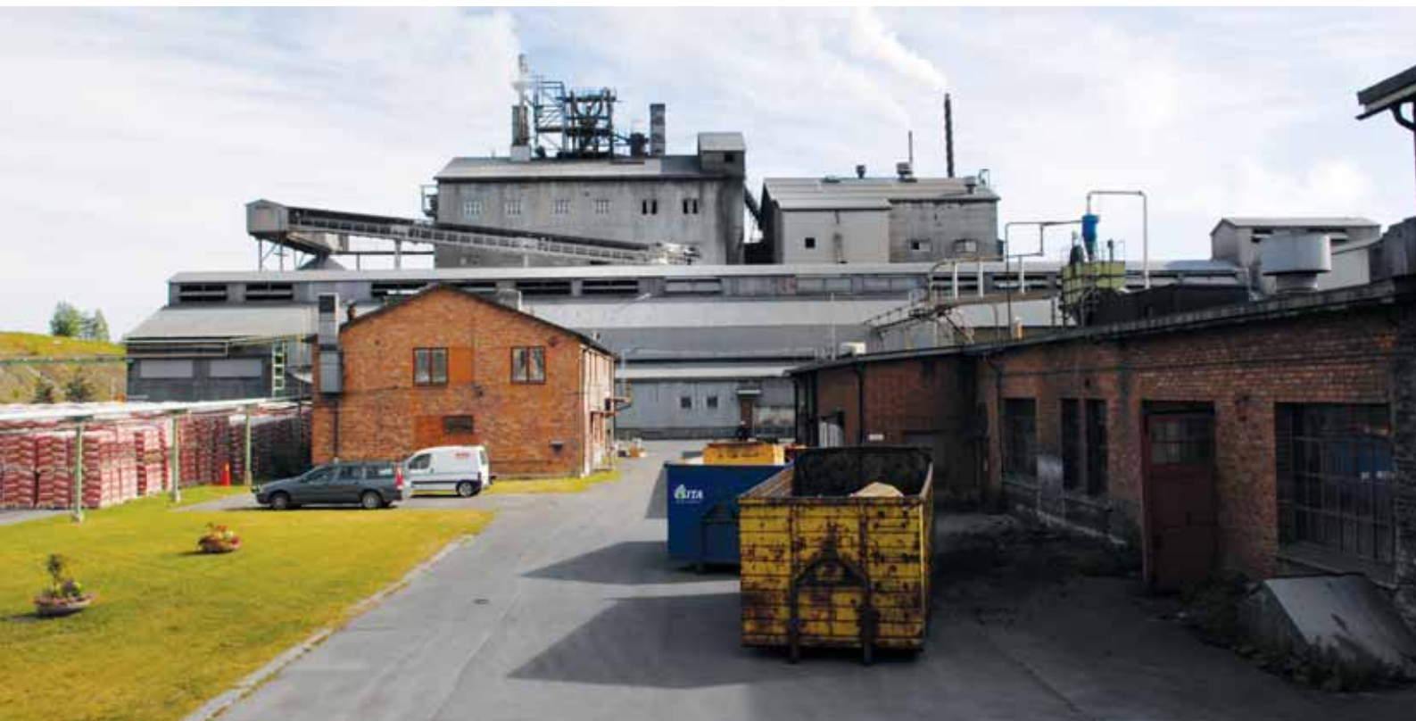
Vy från söder med ugnshuset i bakgrunden och kylhuset framför. I den mindre tegelbyggnaden finns kontor och laboratorium. Tegelhuset till höger är den före detta elektriska och mekaniska verkstaden. Foto SOA 2007
