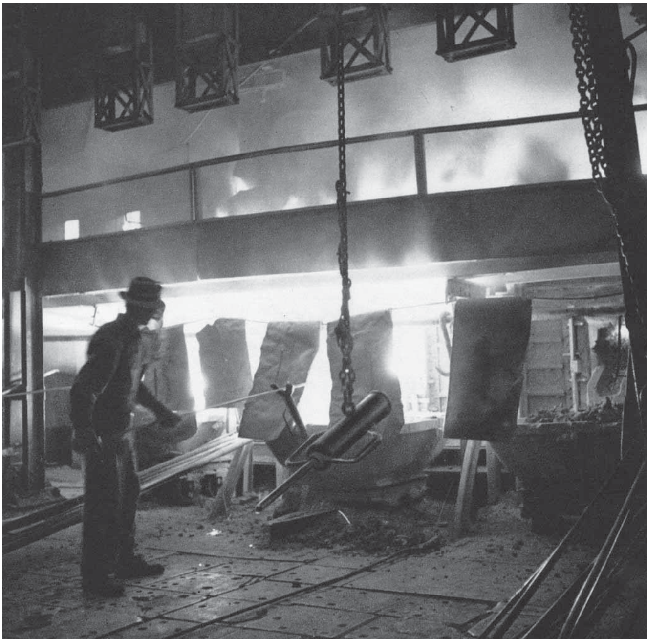
Karbidugnen i Ljungaverk. Stilstudie av tapparen som slår hål på smältan med en järnlans. Notera plåtskyddet mot strålningsvärmen och ugnsgaserna som strömmar upp ur den öppna ugnen. Arkivfoto Carbide Sweden AB, Stockvik
