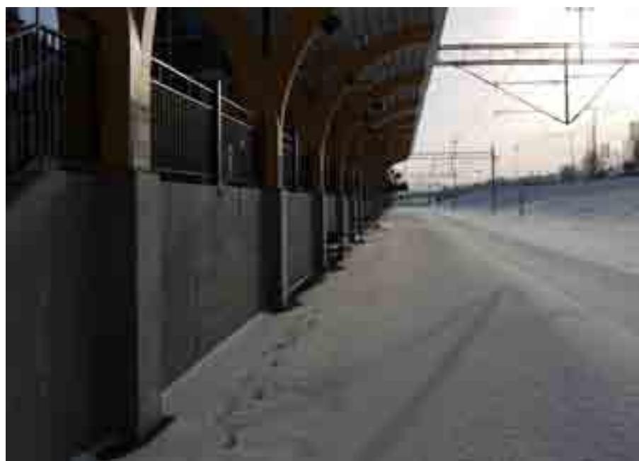
Figur. 26: En ny vägbro och GC-väg är byggd i södra delen av kramfors som anas i bilden ovan.
