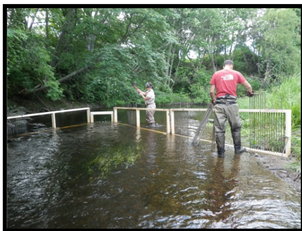
Älandsån vid betydligt lägre flöde i juni 2012 när räknaren monteras. Foto: David Jonsson
