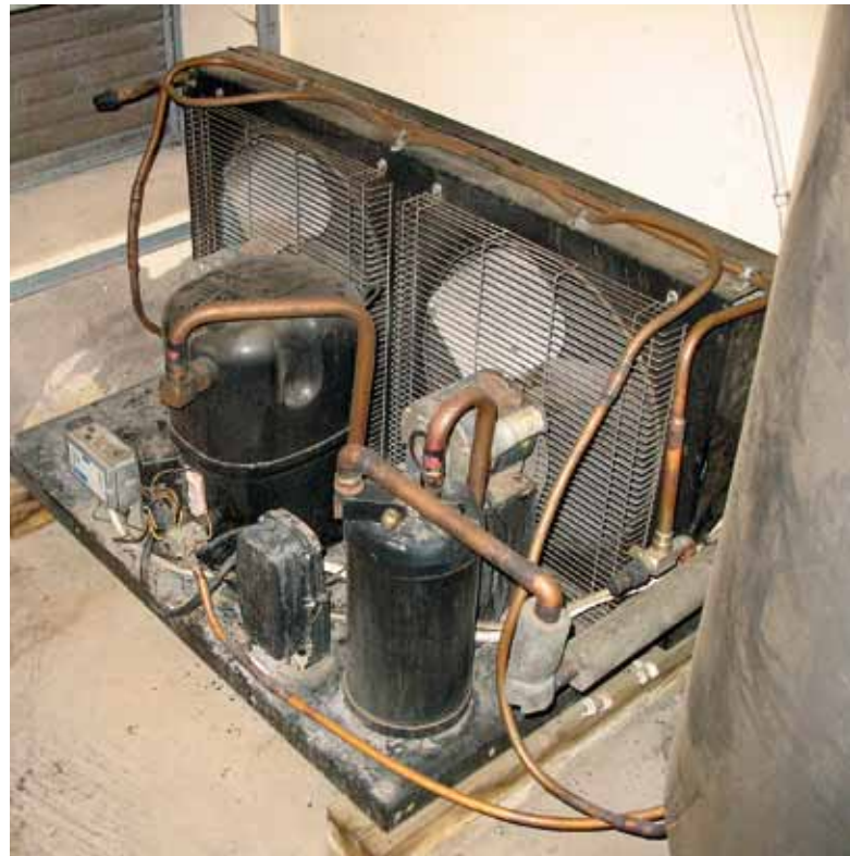
Kylaggregatets placering har stor betydelse för mjölktankens energianvändning. Foto: Lars Neuman
