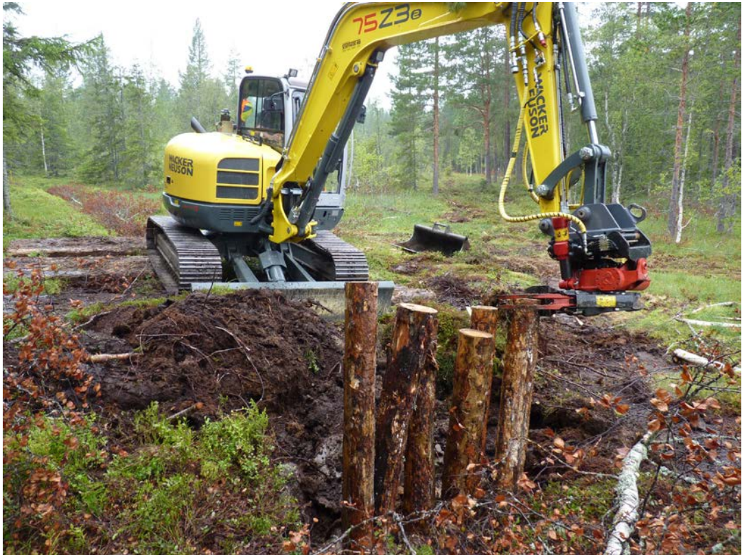
Figur 18. Dikesigenläggning i Sör-Lappmyrans naturreservat. Med hjälp av träd som växt i dikeskanten tillverkas pålar som körs ner i diket. Det stoppar upp vattnet och skapar en mer naturlig hydrologi i myren. Foto: John Granbo, Länsstyrelsen Västernorrland.
