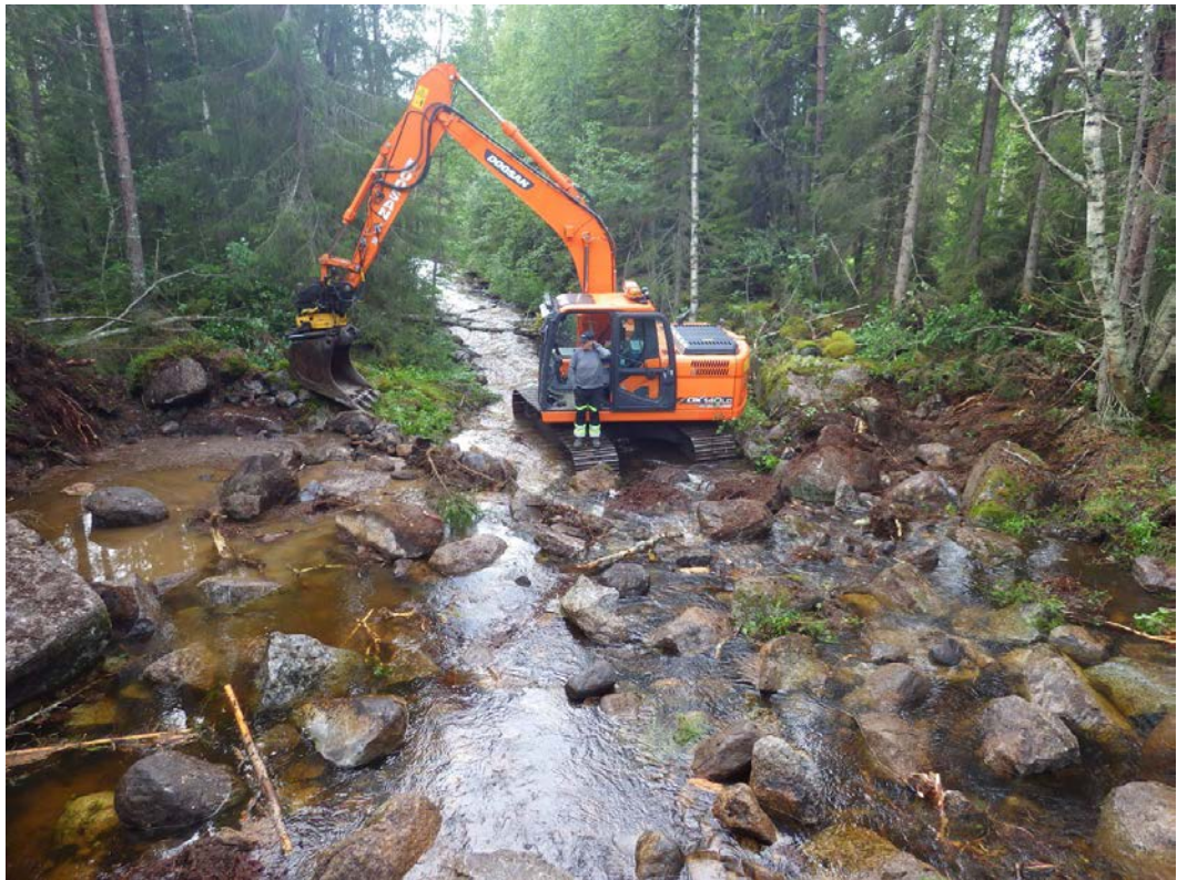
Figur 16. Återställning av Bredsjöbäcken i Hemlingsåns naturreservat. Bredsjöbäcken har liksom flertalet vattendrag i länet tidigare utnyttjats för flottning och under den epoken rensades sten och block från vattendragsfåran för att underlätta timmertransport. Återställningen ger en mer naturlig och heterogen miljö med plats för större biologisk produktion och diversitet, såväl under som över vattenytan. Vattendragets ytutbredning och vattnets uppehållstid i landskapet ökar vilket leder till minskat näringsläckage och minskad risk för översvämningsskador i de större vattendragen nedströms. Länsstyrelsen har medverkat med finansiering och kompetens till en lång rad liknande återställningar i länets vattendrag. Foto: Oskar Norrgrann, Länsstyrelsen Västernorrland.
