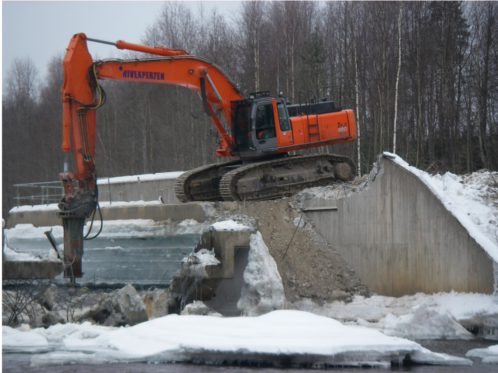
Figur 1. Rivning av kubadammen. Foto: Håkan Söderberg.
