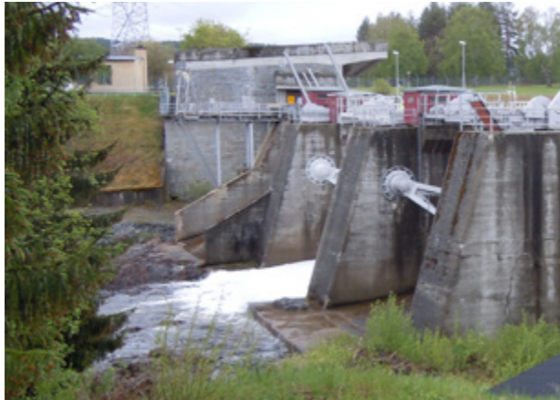
Hjälta kraftverk. Foto: Lars Engström
