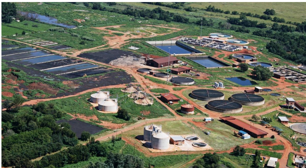
Avloppsreningsverk, avloppsledningsnät och enskilda avlopp påverkar vattenmiljön på flera sätt.
