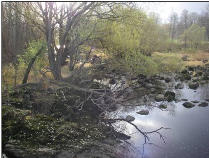
Figur 3. Arbogaån 2 – Grindberga övre. Foto från damm och nedströms.
