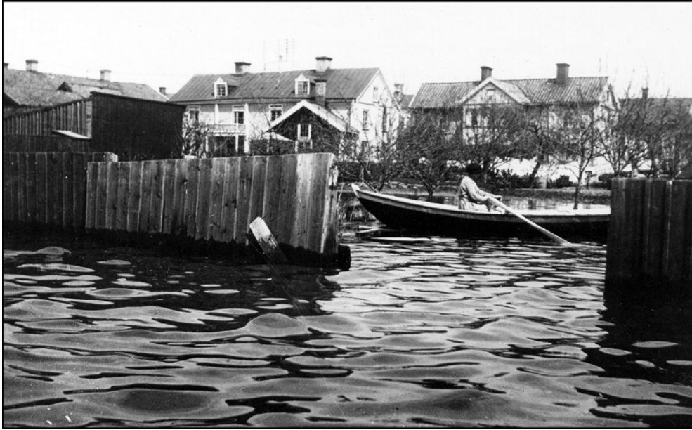
Figur 10. I Mariefred stod vattnet knähögt på vissa håll. Bilden är tagen från Munkhagsgatan mot kvarteret Garvaren. Det stora ljusa huset till vänster var telegrafstation. Foto: Lindmark.
