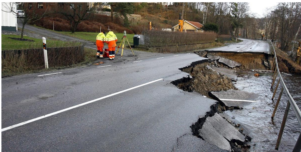
Erosion och bortspolning av vägbank. Mild vinter i kombination med regn kan orsaka stora problem i bebyggelse och infrastruktur. Foto: Åke Thim / SCANPIX.
