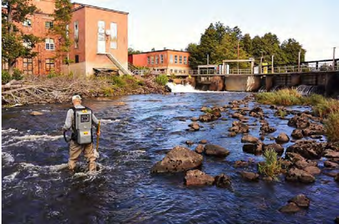
Elfiskelokal "Sörstafors". Turbinhus och dammar i bakgrunden.
