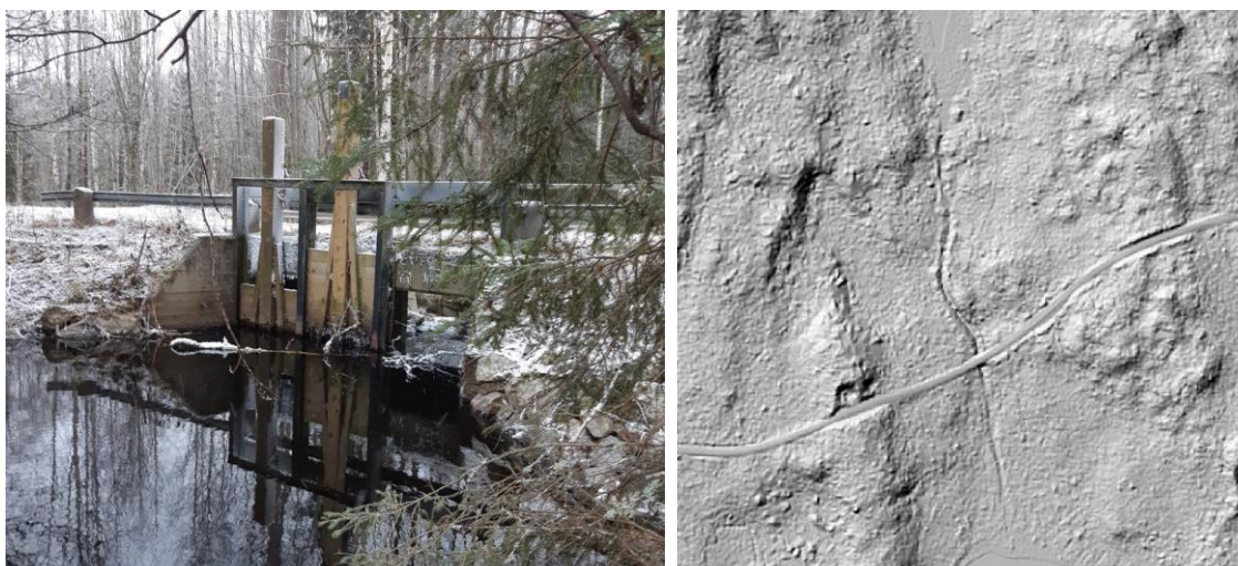
Figur 33. Bild till vänster: Dämme vid utlopp från St. Kedjen. Dämmet är kombinerat med en grusväg. Uppströms (mot förgrunden) finns en smalare passage innan delen av st. Kedjen som kallas Åltjärnen. Dämmet är ett definitivt vandringshinder. Bild till höger: Kartbild med terrängskuggning visar att det finns en mindre bäck mellan St. och L. Kedjen väster om Åltjärnen. Bäck/diket ser rensat ut.
