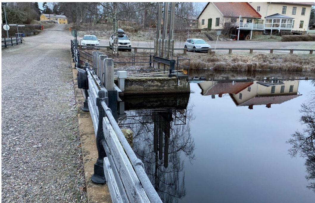
Figur 26. Dammen i Färna samhälle som utgör ett definitivt vandringshinder. Utskovsluckorna syns i mitten av bilden. Den indämda delen syns till höger.
