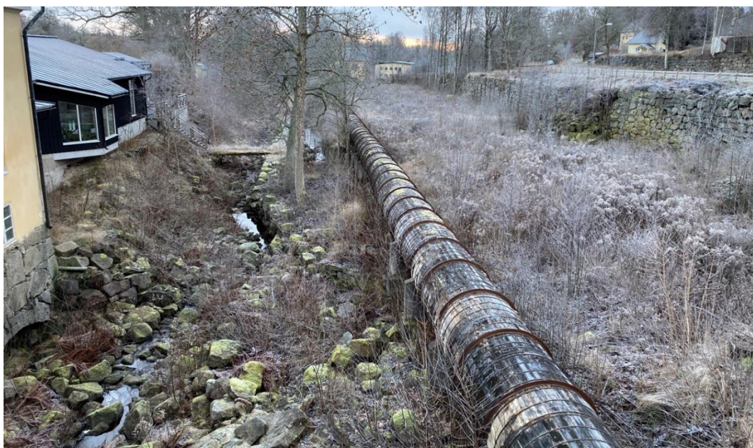
Figur 25. Från delsträcka 2. Naturåran är helt torrlagd och vattnet leds genom trätuben till kraftstationen längre nedströms.
