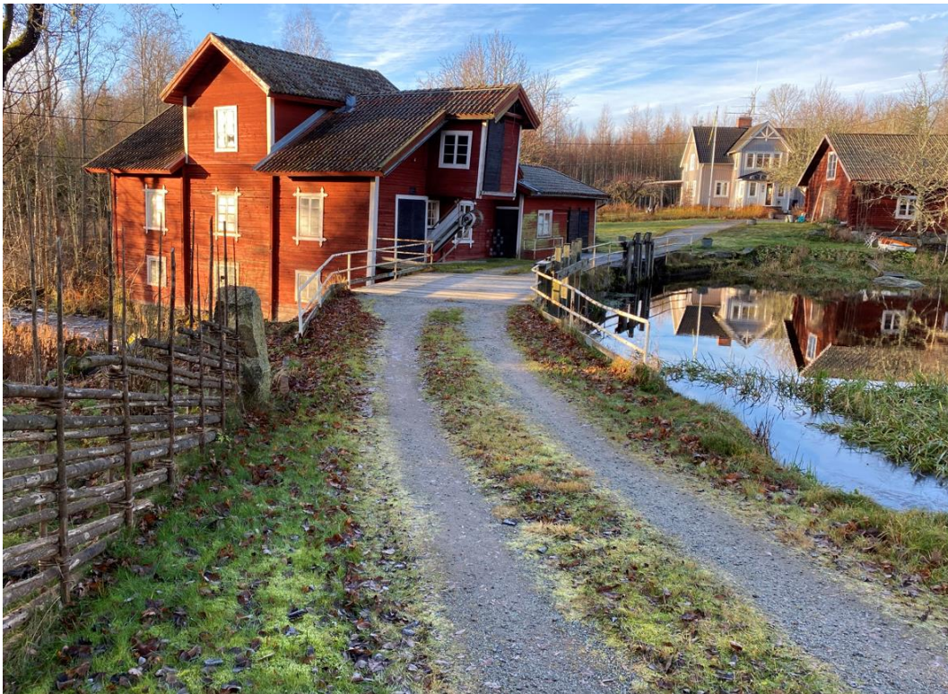
Figur 13. Lämma kvarn. Äldre kvarndamm i nedre Prästhytteån. Till höger syns vattenspegeln i dammen – delsträcka 5.
