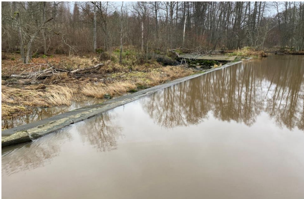
Figur 18. Från delsträcka 13. Visar dämnet vid Strömsnäs kraftverk. Till höger i bild syns den indämda delen. Till vänster syns torrfåran. Vid inventeringstillfället rann det en mindre mängd vatten över dämnet och genom torrfåran.
