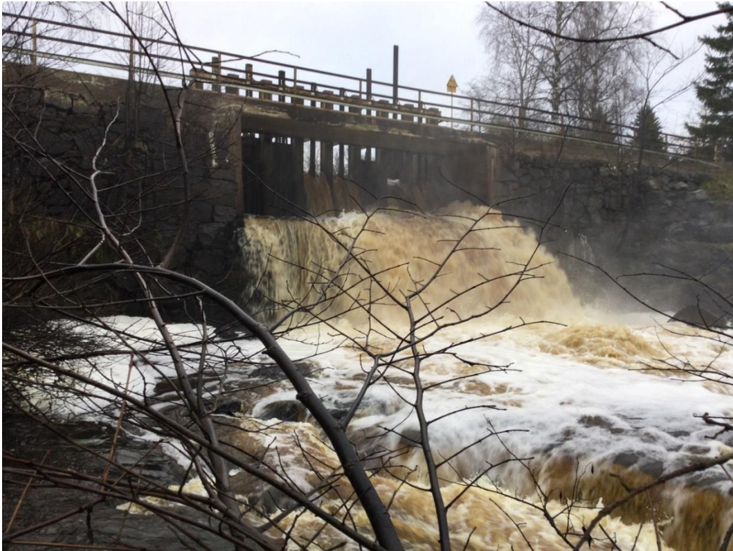
Figur 9. Den nedre dammen vid Svanå bruk (Kvarndammen/Svanå nedre) som utgör ett definitivt vandringshinder.
