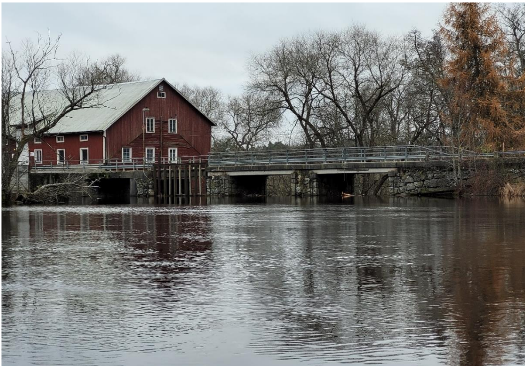
Figur 11. Uppströms dämnet vid Harakers kvarn. Över dammkonstruktionen går en bilväg, i fotot går det även att se de öppningar mellan brofundamenten där vatten släpps.
