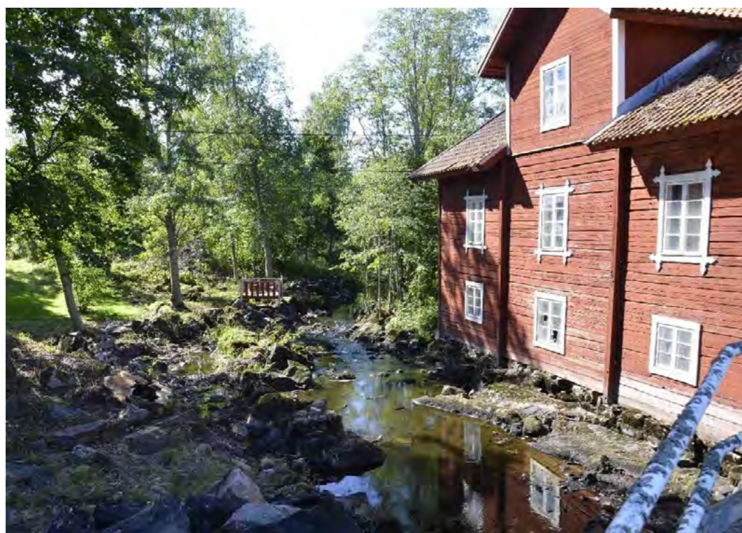
Figur 95. Nedströms vattenfåran vid Västerby kvarn. Lågvatten råder vid fototillfället. Foto mot söder.
