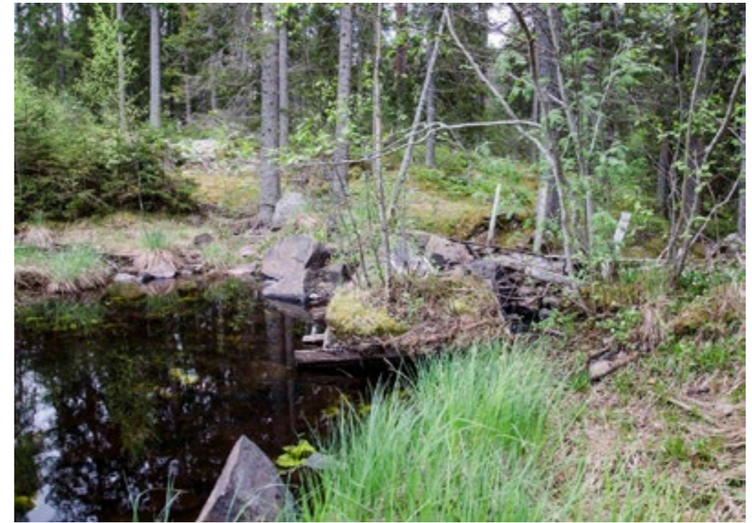
Figur 19. Del av dammvall vid kvarnlämning söder om Värilingsberg (Norberg 162:1). Foto mot sydost.
