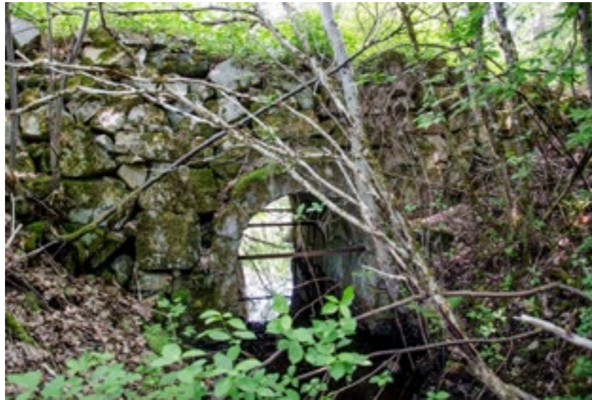
Figur 26. Stenbro (Norberg 306:1) vid Nyhyttan. Slaget valv av slaggsten. Foto mot nordöst.
