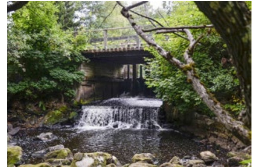
Figur 109. Nedströms övre dammen. Foto mot nordväst.
