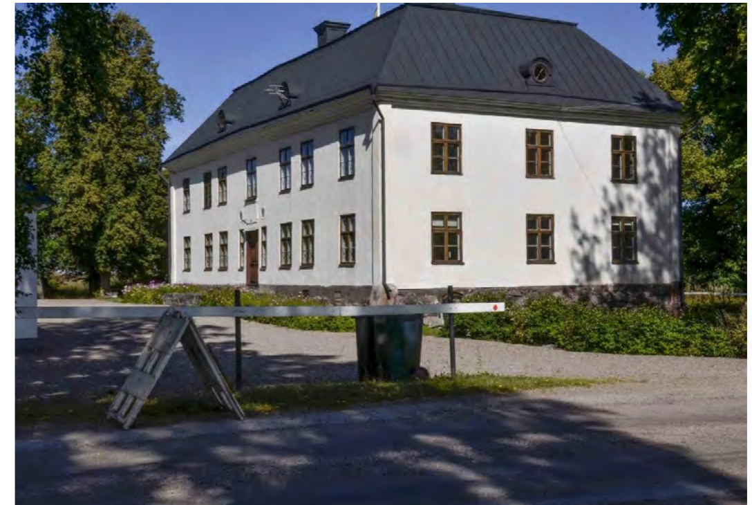
Figur 88. Huvudbyggnaden vid Högsjöfors Bruk (f d Forss) uppförd 1687 av Per Gyllen-hök. Foto mot norr.
