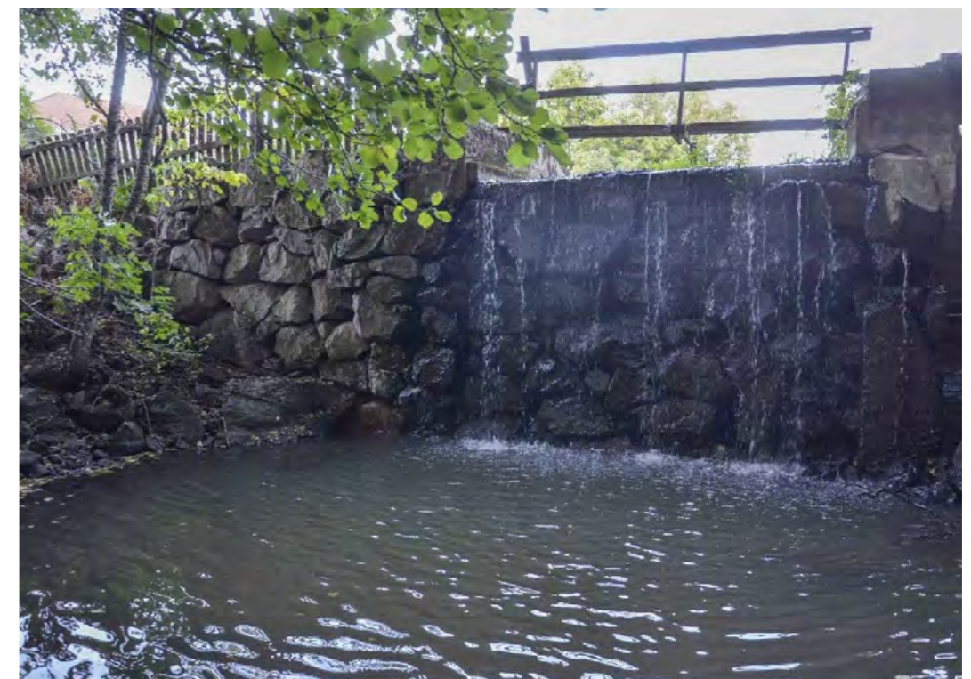
Figur 121. Nedströms dammvallen. Här syns det fint kallmurade stenmaterialet. Foto mot nordöst.
