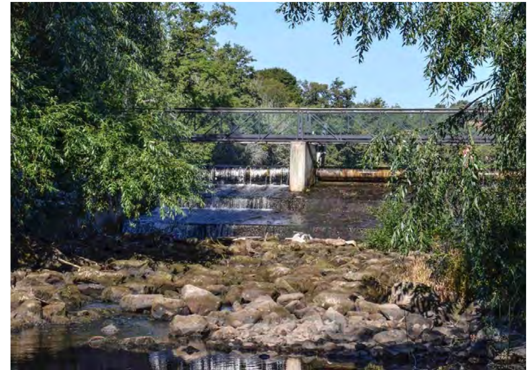
Figur 152. Kraftverksdammen. Foto mot nordväst.
