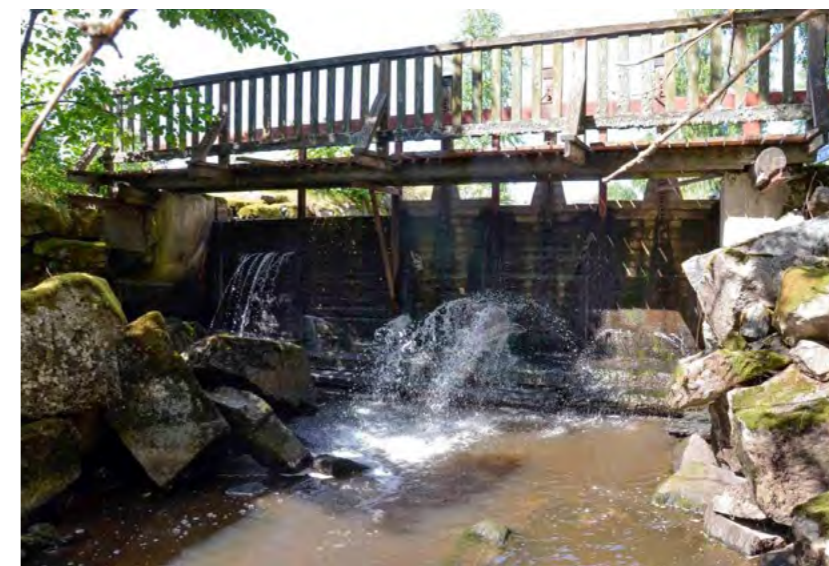
Figur 53. Dämet vid Karbenning 39:1-2 är ett utpekad vandringshinder. Foto mot nordväst.
