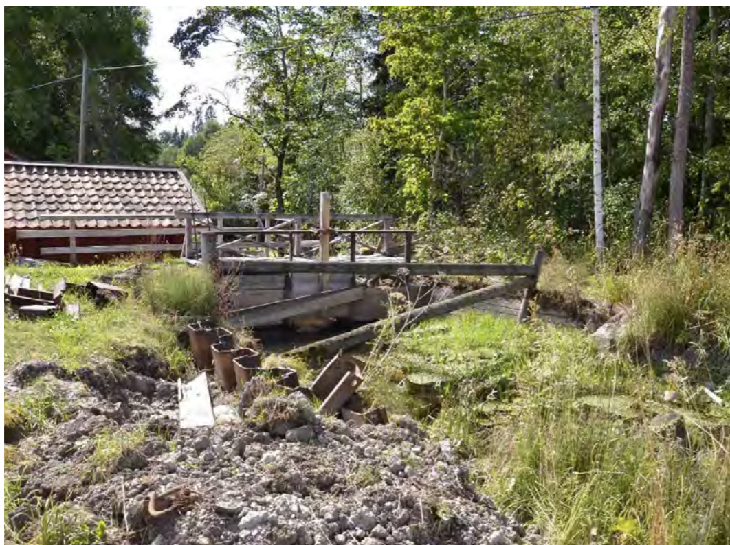
Figur 56. Turbinhuset sett uppströms. Foto mot söder.
