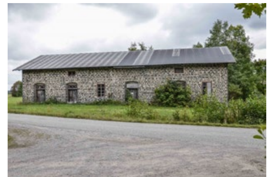
Figur 111. Järnmagasinet omnämnt i riksintressebeskrivningen. Foto mot söder.
