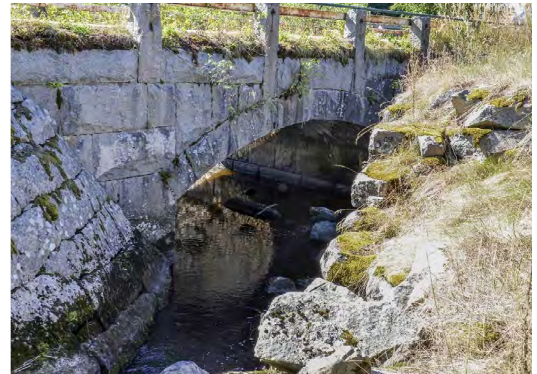
Figur 93. Stenvalvbro under den äldre landsvägen över Prästhytteån. Foto mot sydväst.
