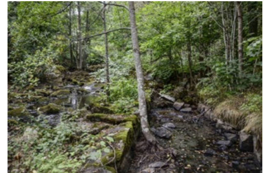
Figur 110. Stensatt och kallmurad vattenränna vid Klensmedjan nedströms det övre fallet. Foto mot norr.
