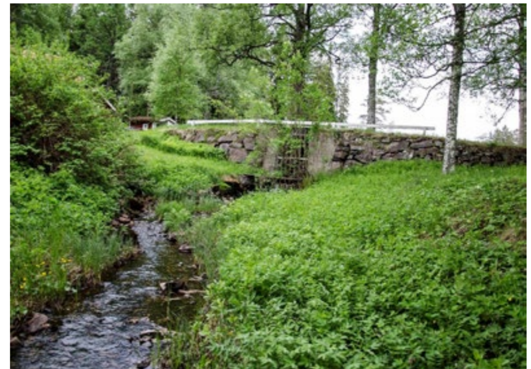
Figur 30. Nedströms dammen med urschaktad och omrörd hyttplats vid Järnhyttan (Norberg 160:1). Foto mot norr.
