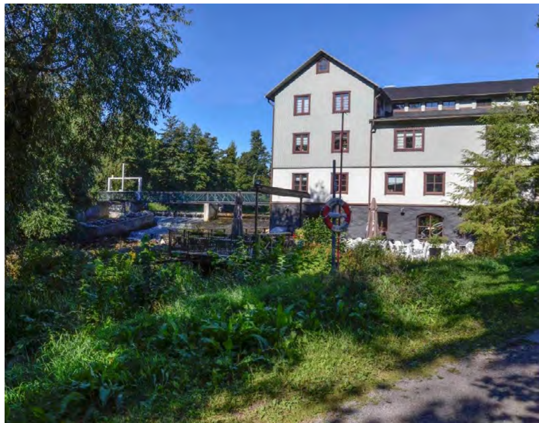
Figur 151. Nedströms kvarnbyggnaden med kraftverksdammen. Foto mot väster.
