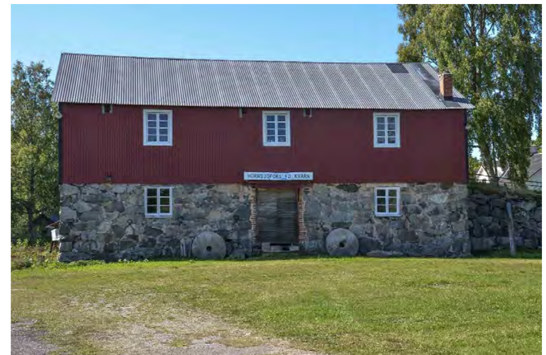
Figur 89. Söder om huvudbyggnaden och vägen som leder över Svartån ligger Hörsjöfors f.d. kvarn. Nedanför huset (till vänster i bild) låg tidigare ett tegelbruk. Foto mot väster.
