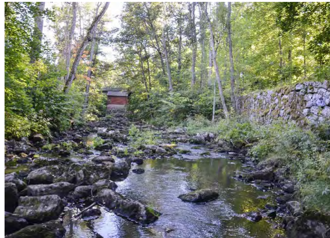
Figur 135. Den västra åstranden är här stensatt med fint kallmurade stenar (Skultuna 224:1). I bakgrunden skymtar del av fundamenten till den äldsta bevarade bron i området, Brännugnsbron. Islossning och vårflooder gick hårt åt träkonstruktionerna i vattendraget, varför det krävdes förstärkningar och stenbroar vid de mest utsatta partierna. Foto mot söder.
