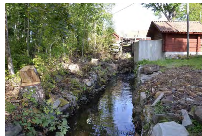
Figur 54. Dämet vid Karbenning 38:1 är ett utpekad vandringshinder. Foto mot nordväst.
