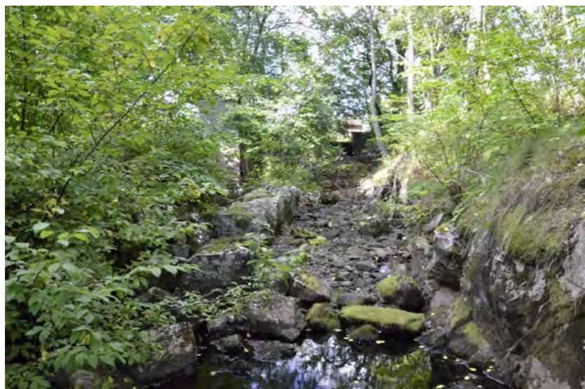
Figur 73. Till vänster i bäckfåran kan anas både ränna för vattenhjul och turbinhus av cement. I bakgrunden dammen. Foto mot norr.
