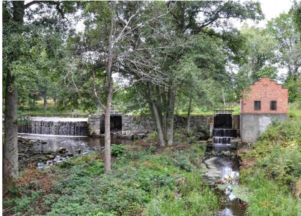
Figur 142. Damm och kraftstation vid Forsby. Foto mot nordväst.
