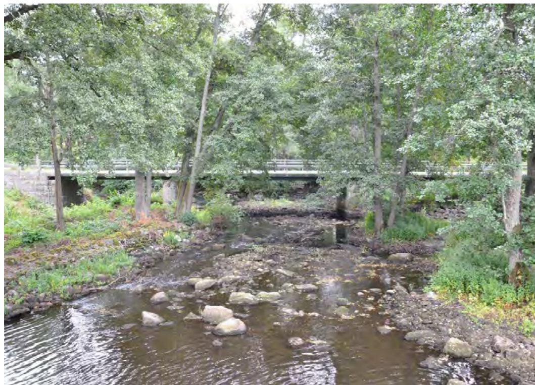
Figur 143. Nuvarande vägbron vid Forsby sett från dammen. Foto mot sydöst.
