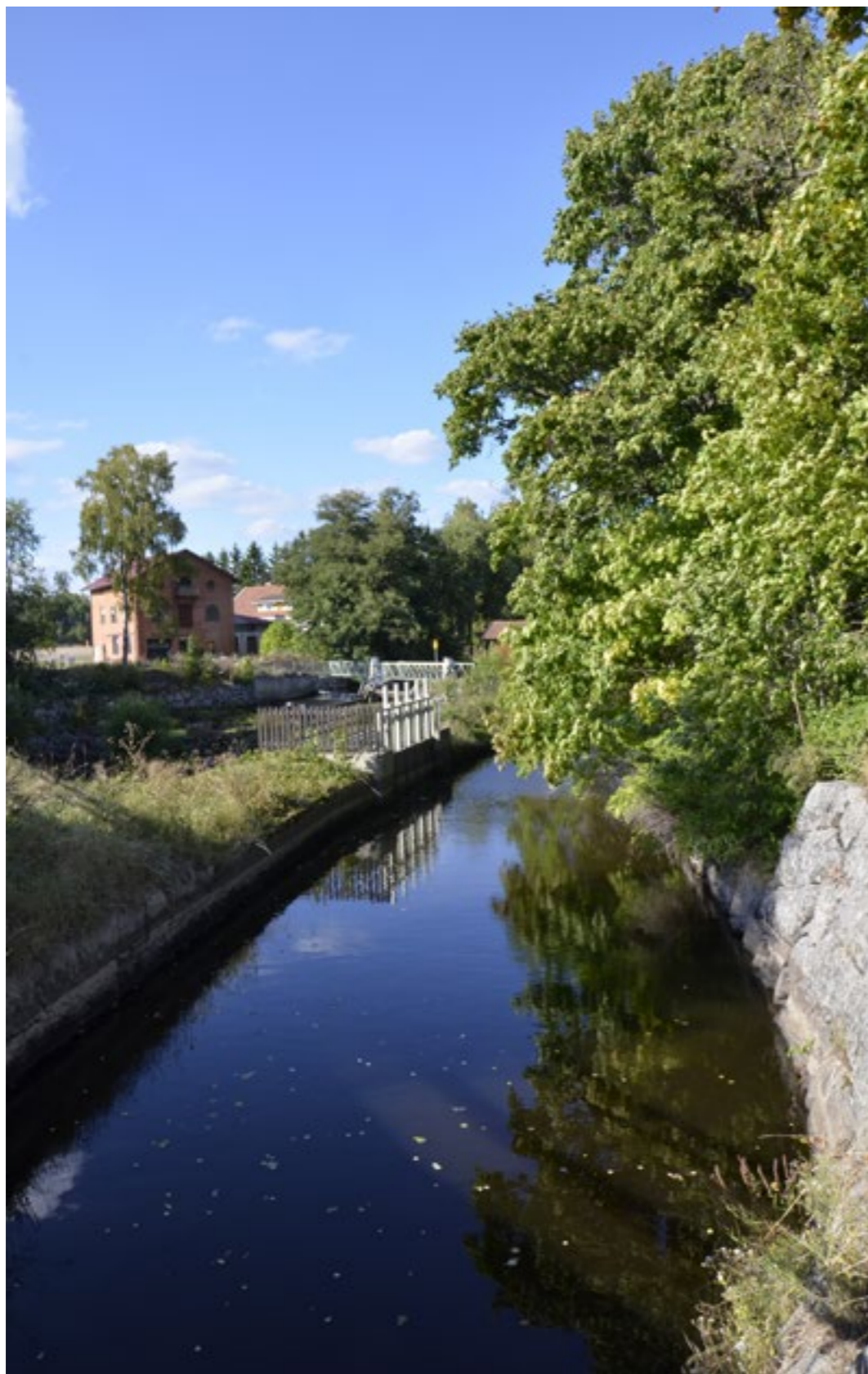
Figur 5. stensatt kanal till Backa kvarn i Skultuna. foto mot söder.
