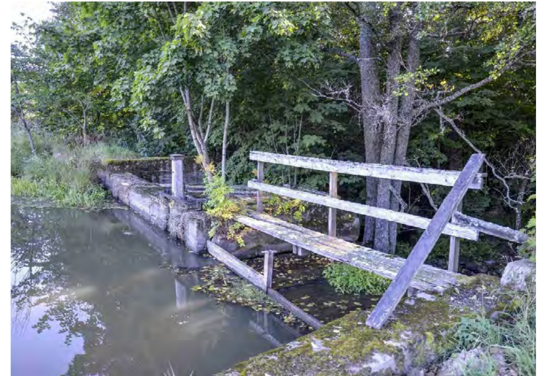
Figur 120. Spång över dammen. Foto mot söder.
