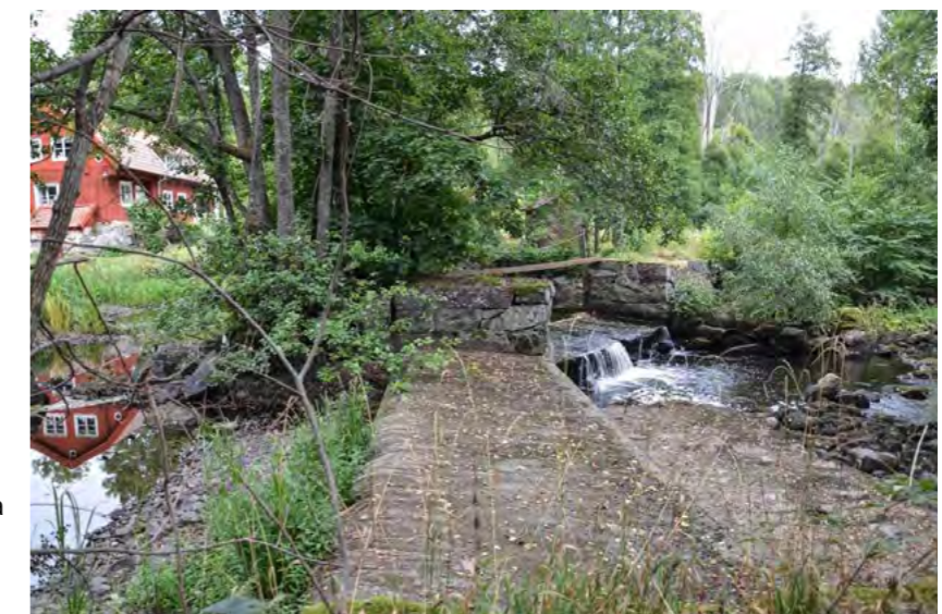
Figur 146. Den västra delen av dämet utgörs av cement. Foto mot nordöst.
