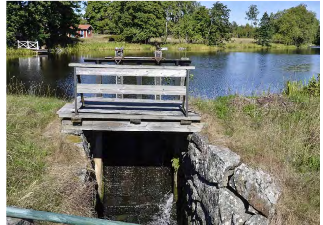
Figur 92. En av dammluckorna vid landsvägsdammen (Västerfärnebo 505:1). Foto mot norr.
