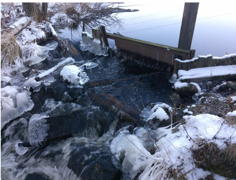
Figur 10. Raserad regleringsdamm vid utloppet av Bjursjön (åtgärdades i september 2018)
