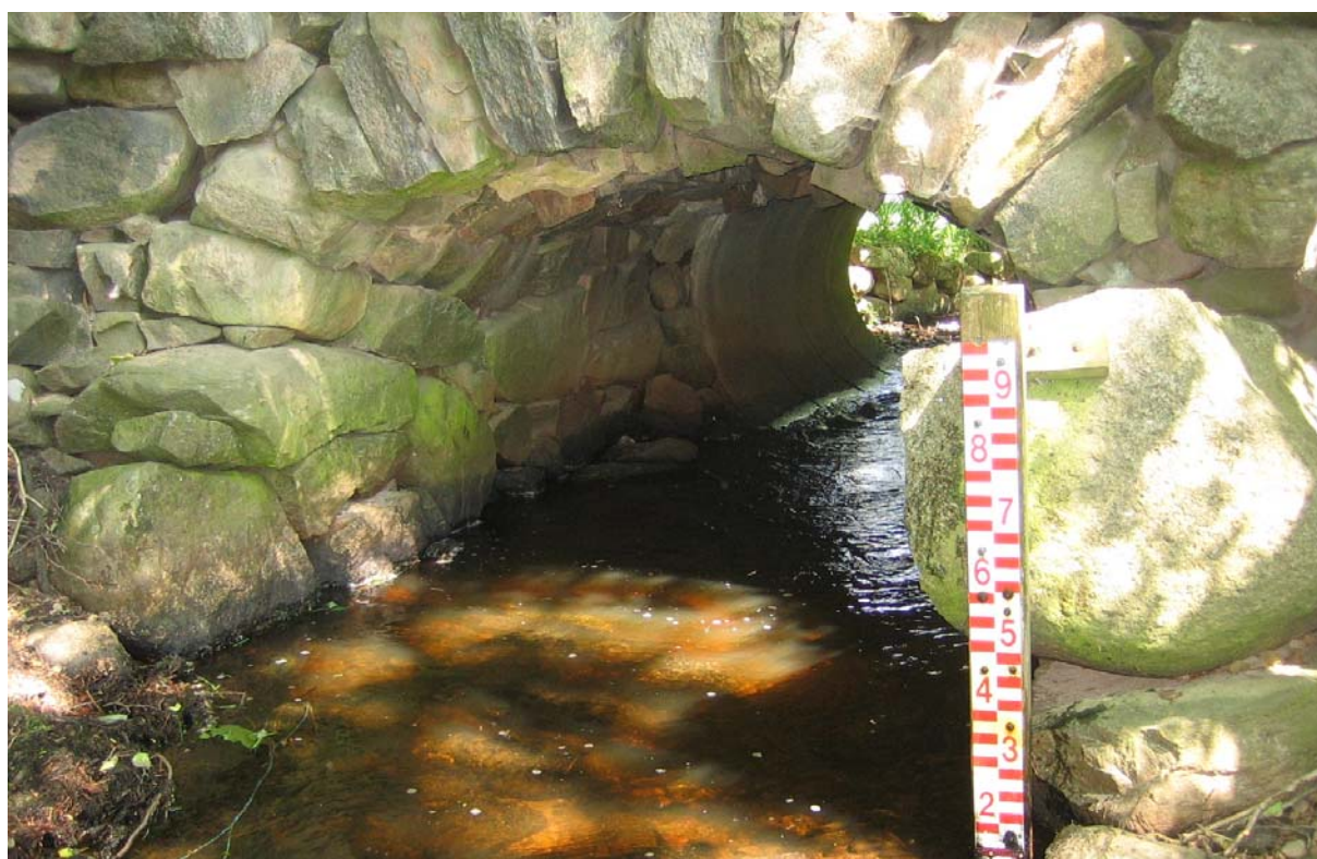
Figur 10. Vattendomstolen har meddelat tillstånd till uttag av vatten för jordbruksbevattning. Minimiflödet 50 l per s får inte underskridas genom bevattningsuttag. Motsvarande vattennivå finns angiven på pegelskalan.
