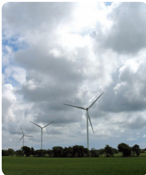
Bild 1. Vindkraftverken i Tvååker, Varbergs kommun. 2004 inledde Varberg Energimarknad AB samråd med myndigheter och allmänhet och 2007 var verken uppförda. De är 130 meter höga, har en effekt på 2 MW per verk och beräknas producera 16 GWh el per år. Fotograf: Sofia Frising
