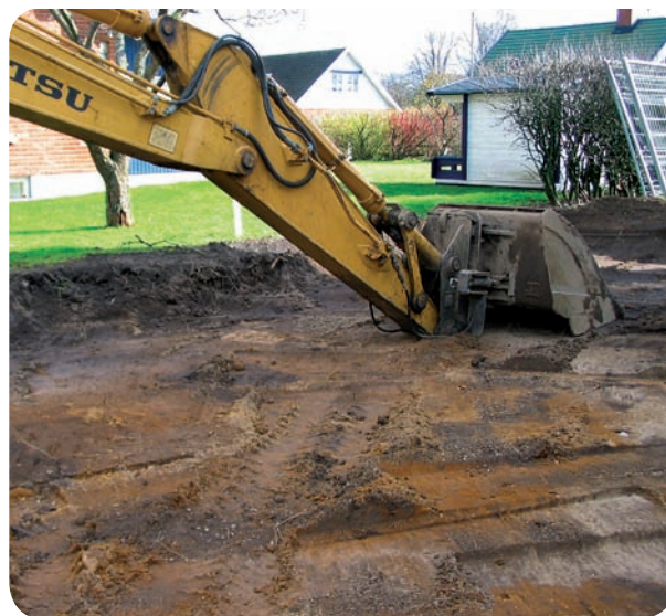
Bild 1. Sanering pågår i Eketånga, Halmstad. Fotograf: Stefan Johansson
