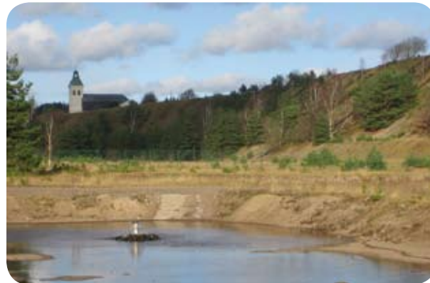
Genom konstjord infiltration av vatten från sjön Lygnern kan grundvattentillgången i Fjärås Bräcka förstärkas och försörjer huvuddelen av Kungsbacka med dricksvatten. Foto: Arne Joelsson
