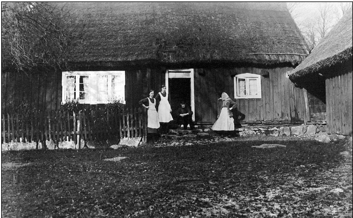
Bollaltebyggets boningshus strax innan loftstugan i mitten byttes ut mot ryggåsstugan från Jonsnahult.
