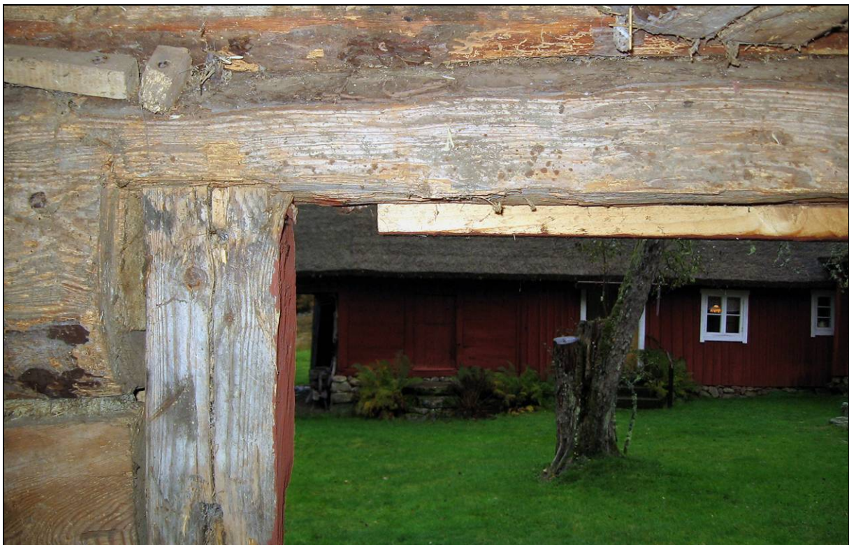
Urfasningen i överliggaren till fähusets dörröppning gjordes på 1920-talet för att hästen skulle kunna komma in. Utsikt mot gårdsplanen med päronträdet och "lillstugan" i bakgrunden.
