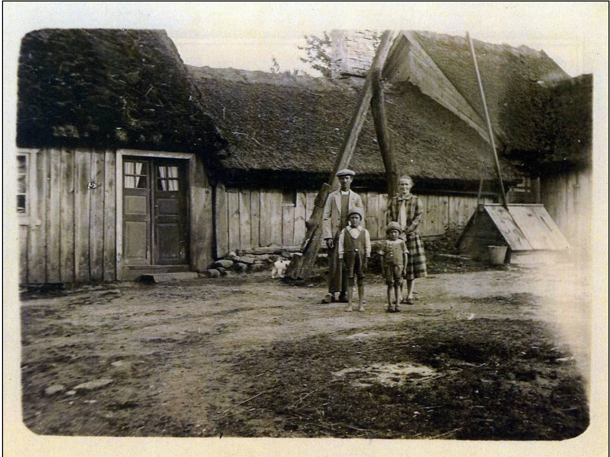
Ryggåsstugan i Jonsnahult före flytten till Bollaltebygget 1937.
