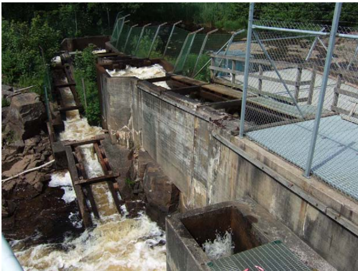
Figur 99. Fisktrappan vid Hertings Kraftverk i Ätran. Foto Nils Ljunggren.
