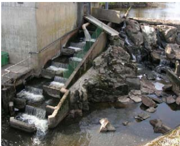
Figur 108. Kraftverket vid Bobergs gård i Suseån. Bassängtrappans utformning med vertikala fall medför att den inte är användbar för nejonögon och andra vandringsvaga organismer. Foto Micael Söderman.
