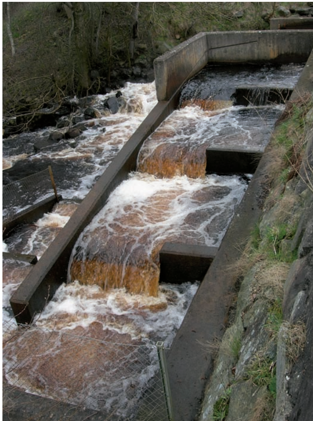
Figur 28. Nejonögonens begränsade vandringsförmåga och obenägenhet att hoppa medför svårigheter i att passera konventionella laxtrappor. På bilden visas bassängtrappan vid Vårestorps kvarn i Smedjeån. Det av humusämnen brunfärgade vattnet medförde att okulär inventering av lekande flodnejonöga var svår att genomföra under våren. Lekgropar av arten kunde dock verifieras under sommarens inventering av havsnejonöga. Foto Micael Söderman.
