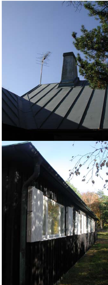
Detaljer av prins Bertils villa. Övre bilden visar delar av taket med skorstenen. Nedre bilden visar den södra fasaden, matsalsfönstret närmast kameran.
