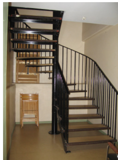
Trappa från källaren upp till scenen i svartmålat gjutjärn kring en gjutjärnspelare med enkelt järnsmidesräcke
