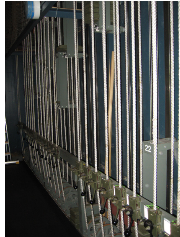
Linsystem för styrning av kulisser och ridån.
