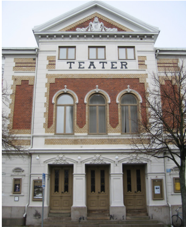
Huvudfasaden, den välartikulerade södra fasaden.
