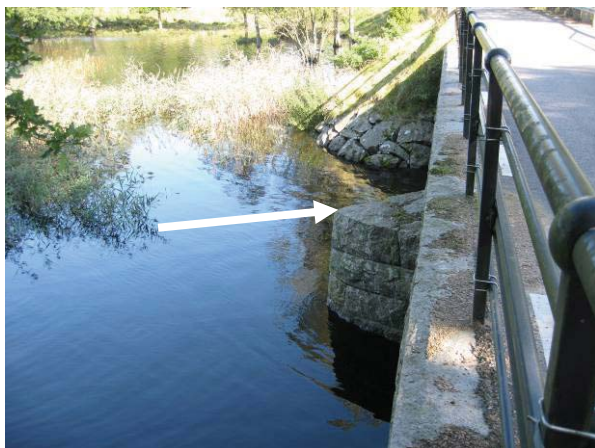
Foto 8 och 9. Fixpunkt i Hjärtaredssjön (övre kant av mittenfundamentet vid bron vid utloppet). Avståndet till vattenytan kan mätas från bron med teleskopkratta, eller från båt. Se även figur 3.
