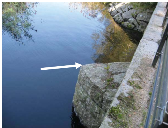
Foto 8 och 9. Fixpunkt i Hjärtaredssjön (övre kant av mittenfundamentet vid bron vid utloppet). Avståndet till vattenytan kan mätas från bron med teleskopkratta, eller från båt. Se även figur 3.
