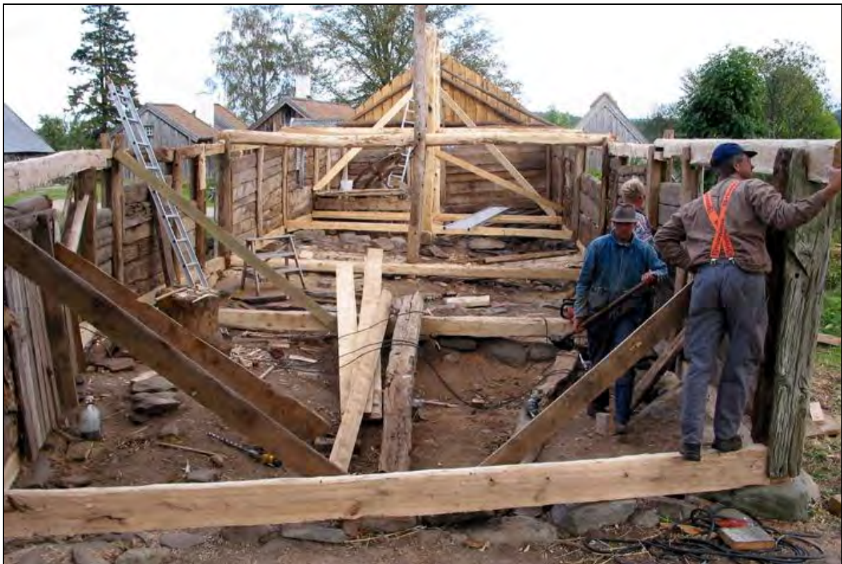
Bengts lada renoverades 2004 med en del nya bärande delar av ek som huggits i Äskhults marker. Ladan är byggd med mesula-konstruktion som innebär att mittställda stolpar bär upp takåsen.
