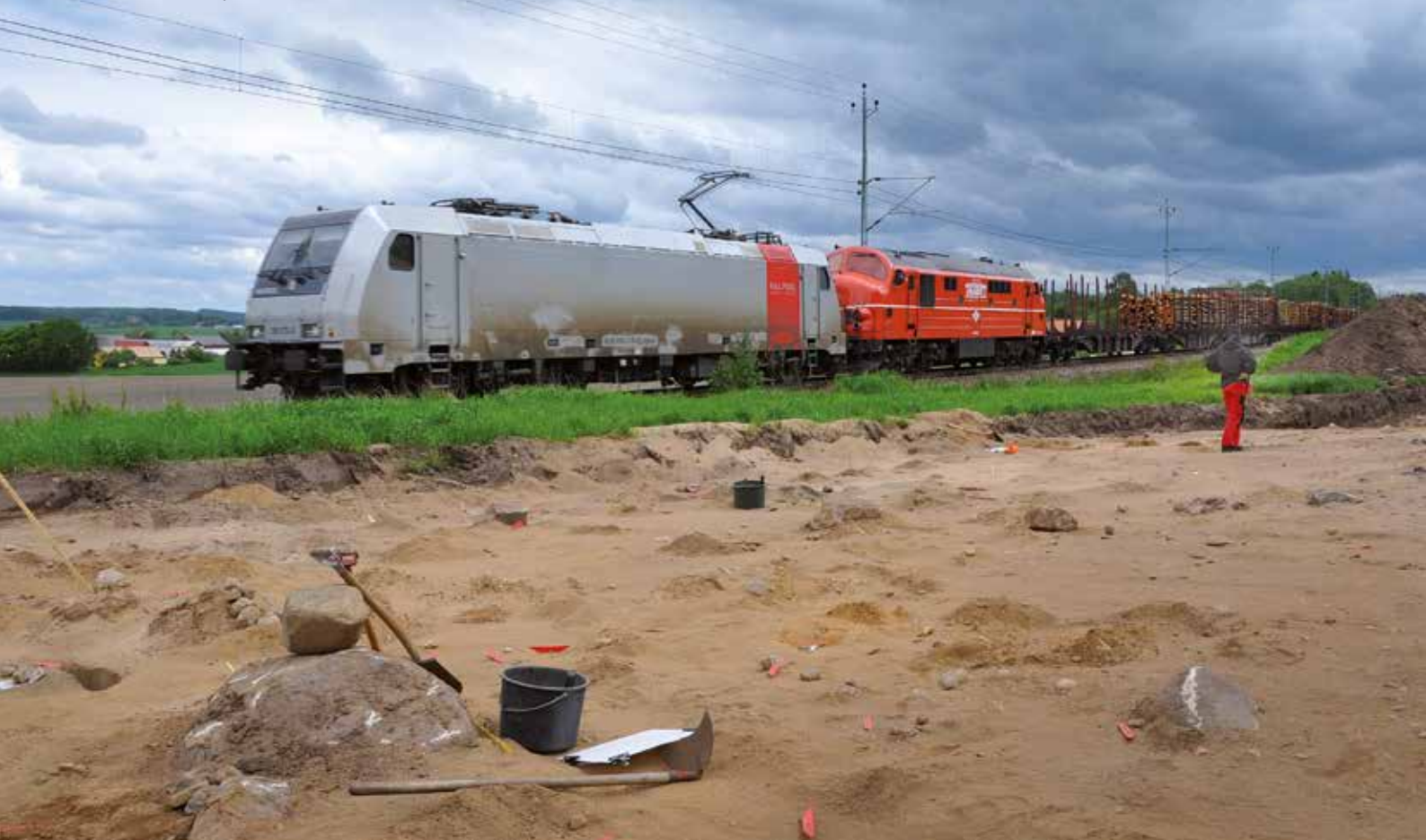
Slutundersökning i Veinge inför anläggande av VA-ledning. Foto: Anna Aulin
