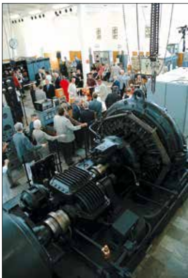
Den unika alternatorn från 1924 används än idag för att alstra långa vågor från Grimeton världen runt. Foto: Arne Persson
