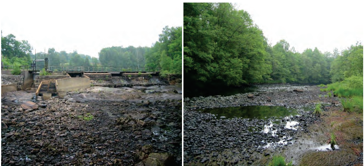
Torrläggning nedströms Marbäck i juni 2006
