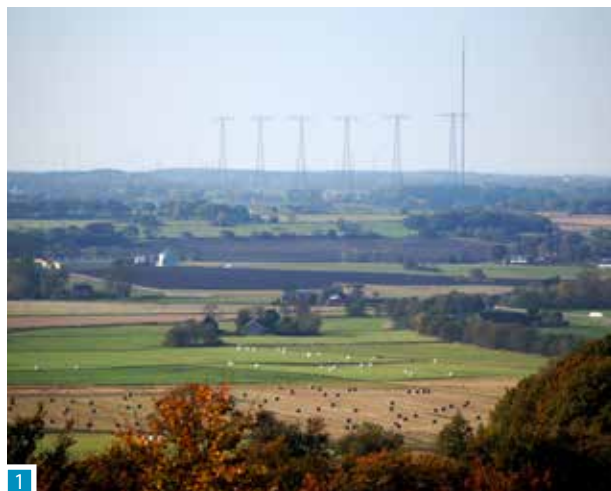
Utsikt mot Grimetonmasterna från Böstesberget.
