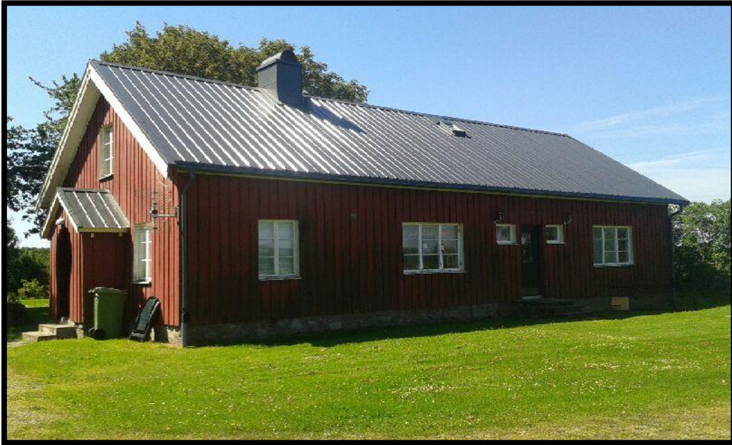
Figur 48: Arrendebostaden, belägen strax väster om mangårdsbyggnaden.
