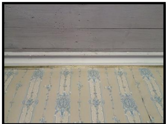
Figur 20: Taklist i matsal på första våningen med guldkant mot tapeten. Detta finns genomgående i huset på båda våningar.
