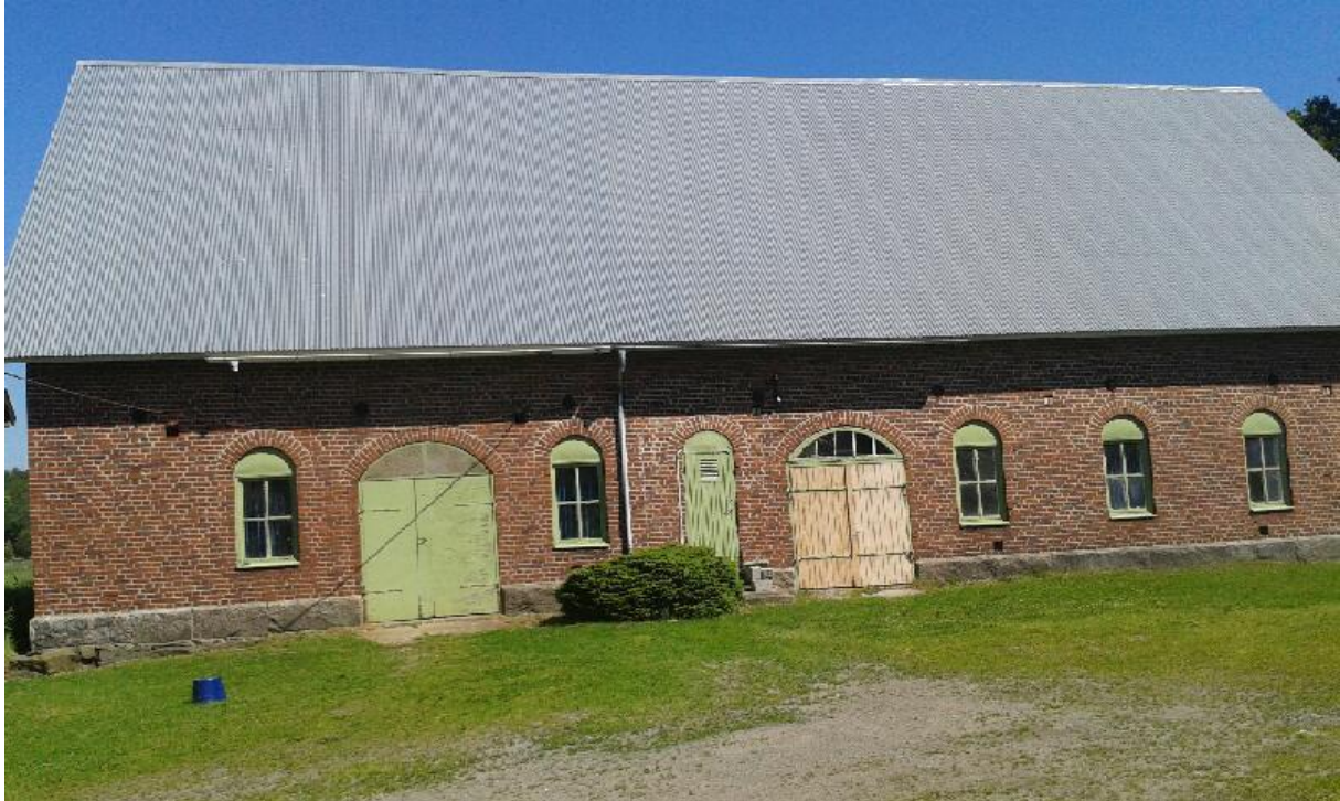
Figur 50: Ladugård från början av 1900-talet. Ladugården har på senare tid fått nytt tak.
