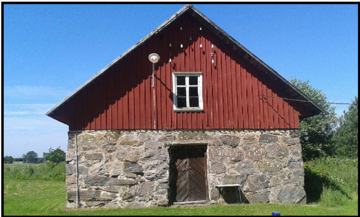
Figur 51: Förrådshus med stenkällare
