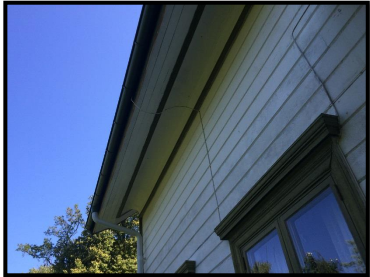
Figur 11: Takfoten och den rundade gesimsen mellan tak och väggliv.
