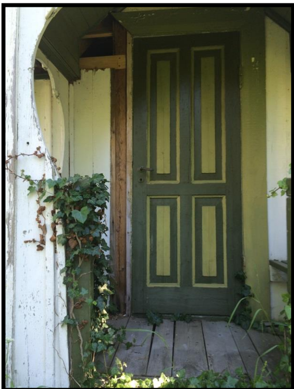
Figur 46: Lusthusets dörm och del av förstukvisten. Murgröna klättrar på fasaden.
