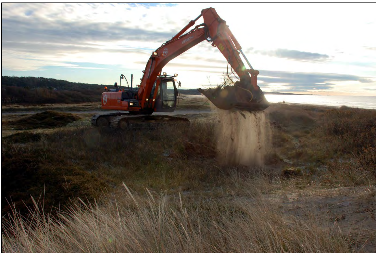
Bortgrävning av stora bestånd av vresros med gallerskopa vid Långasand söder om Falkenberg.
