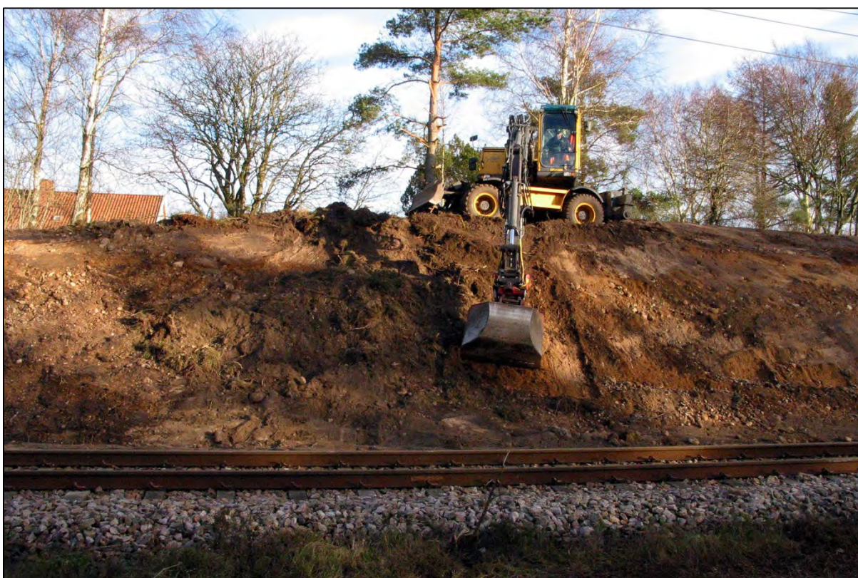
Restaurering av artrika banvallar vid Veinge station i södra Halland. Näringsrik matjord skrapas av för att få fram mager grus och sand igen.
