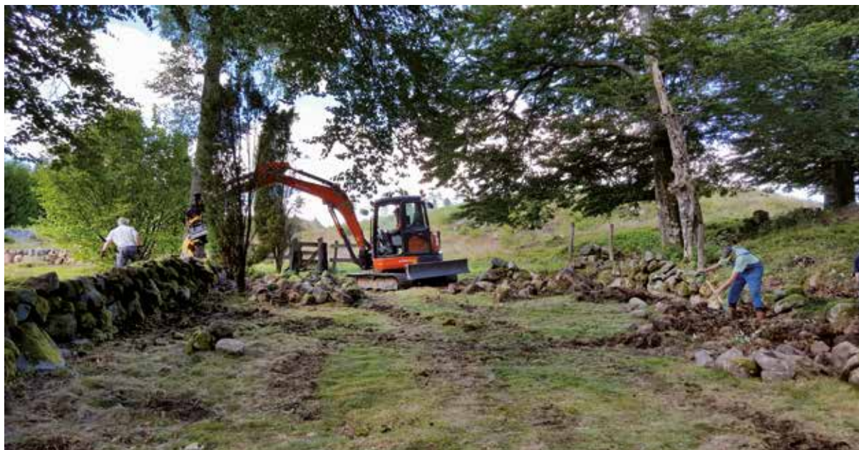
Stenmursrestaurering i Bollaltebygget. Foto: Jenny Nord
