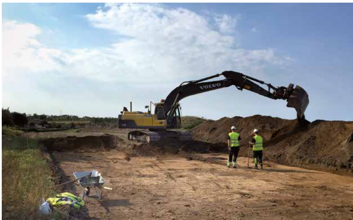
Maskinavbanning av matjord vid Vessingehögen. Från öster. Foto Bo Strömberg.
