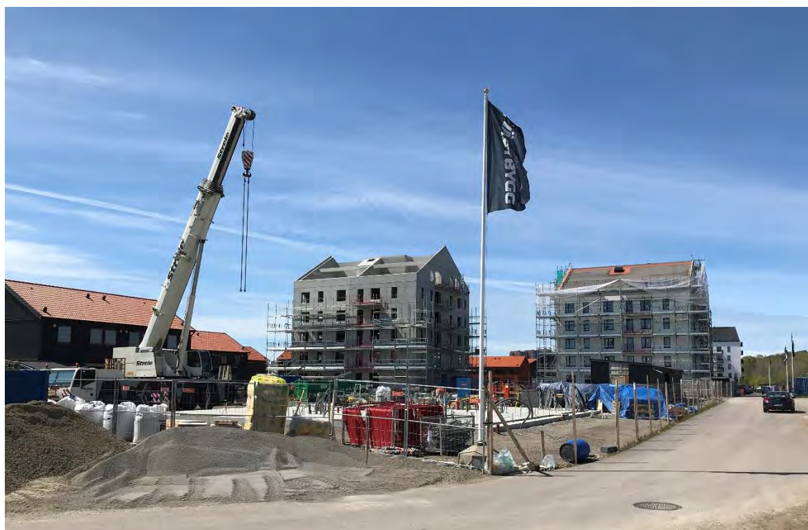
Figur 4. Pågående bostadsbyggnation i Breared Varbergs kommun. Foto Dag Rundegren.
