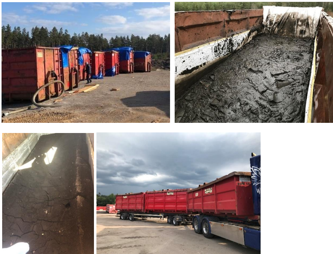
Figur 14. Vid vinterns intåg 2019 flyttades muddrat sediment från Ralångens strand till en mellanlagring i sju täckta containers på ett avfallsupplag i närheten. Fortsatt passiv avvattning pågick under vintern. Ca 30 ton transporterades till pelletstillverkning.
