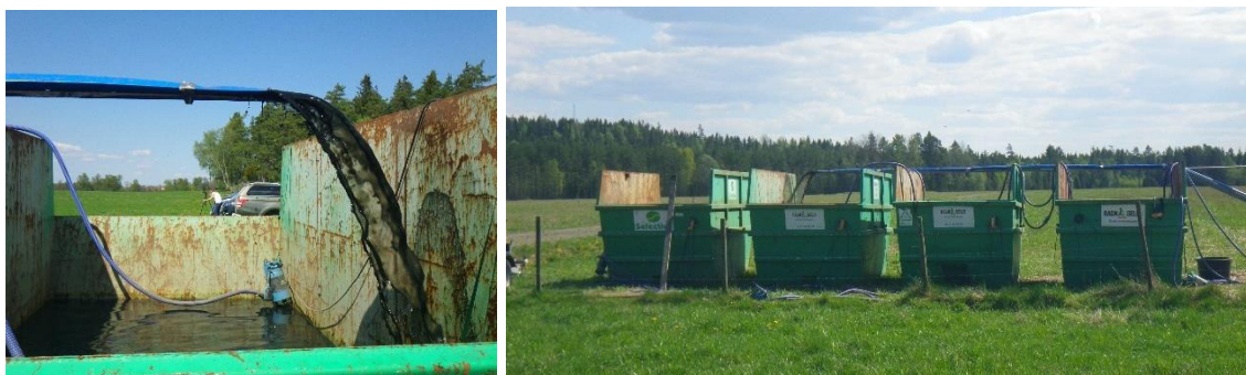
Figur 11. I Barnarpsjön2016 användes passiv avvattning genom sedimentation.
