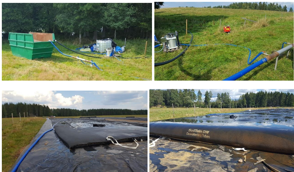
Figur 16. Vid muddring av barnarpssjön, Jönköpings kommun, genomfördes test av avvattningsteknik. Polymer tillsattes vid pumpning av muddrat sediment direkt på slang till geotextiltub. Klarfasen rann därefter igenom geotextilen medan flocken kvarstannade.
