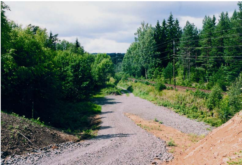
Bild 6. Järnvägsvallen vid bron över sjön Stråken väster om Mullsjö. Sandödlor observerades på båda sidor om järnvägen och längs den norra kanten av grusvägen varifrån bilden är tagen. Lokal 19A, vy mot NV från NÖ delen av lokalen, 23 juli 2004. Foto: A. Lydänge.
