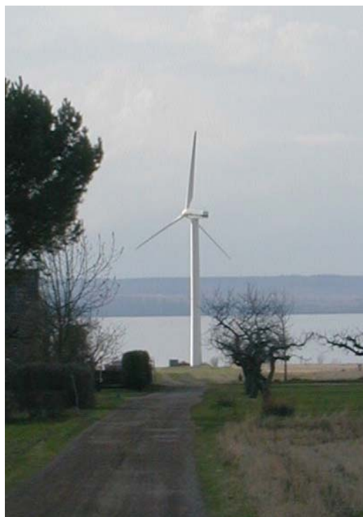
Vindkraftverk på Visingsö. Foto: Länsstyrelsen
